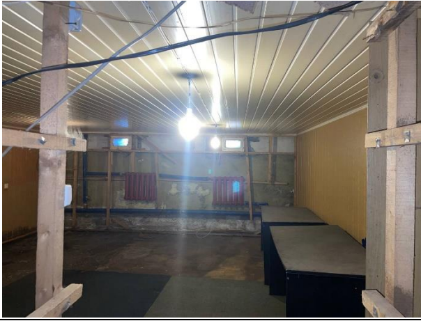
Фото № 15. Внутреннее состояние помещения
