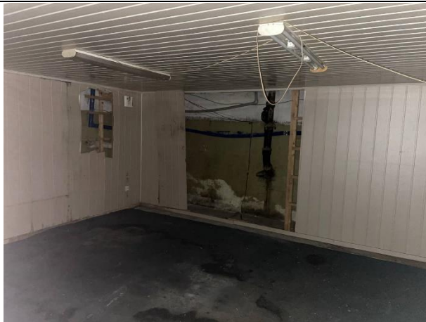
Фото № 11. Внутреннее состояние помещения
