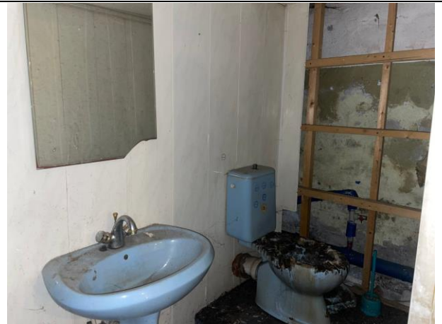
Фото № 12. Внутреннее состояние помещения
