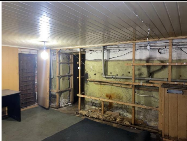
Фото № 13. Внутреннее состояние помещения
