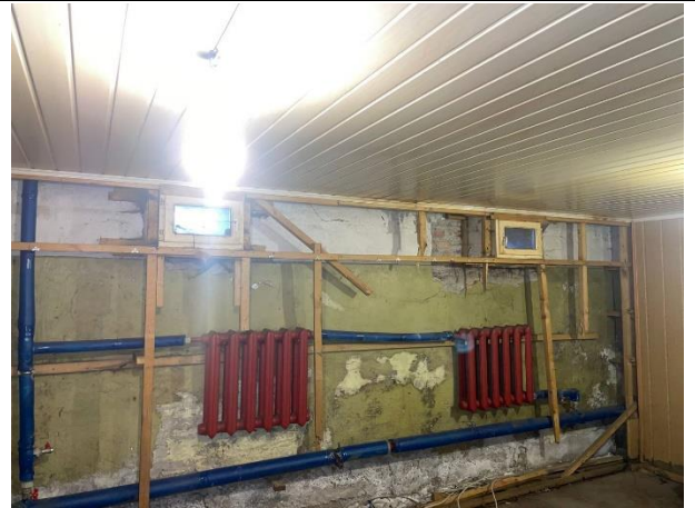
Фото № 10. Внутреннее состояние помещения
