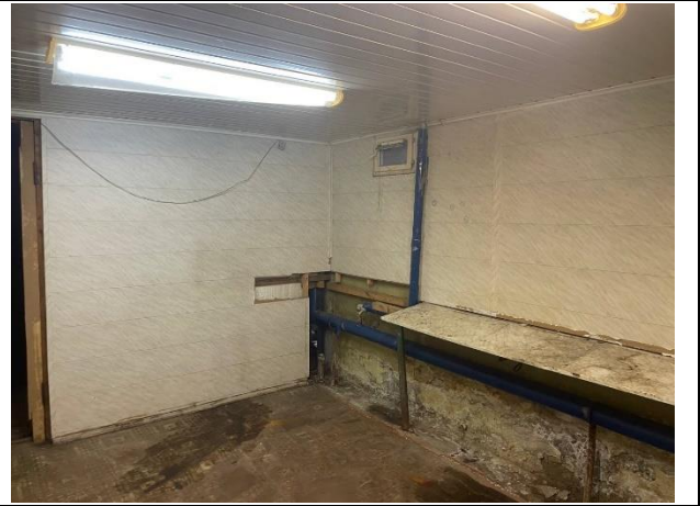
Фото № 24. Внутреннее состояние помещения
