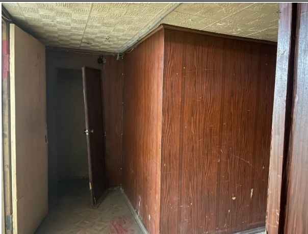
Фото № 21. Внутреннее состояние помещения
