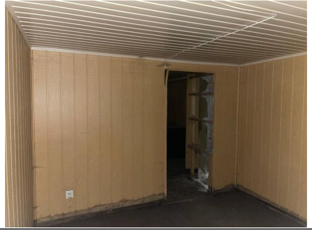
Фото № 16. Внутреннее состояние помещения
