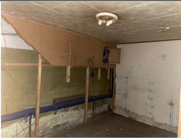
Фото № 19. Внутреннее состояние помещения
