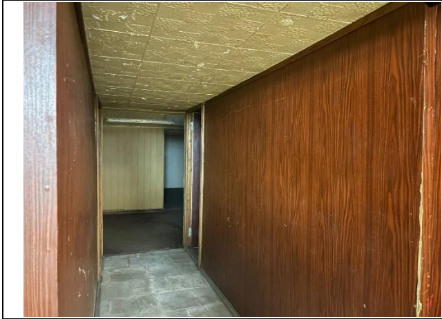
Фото № 23. Внутреннее состояние помещения
