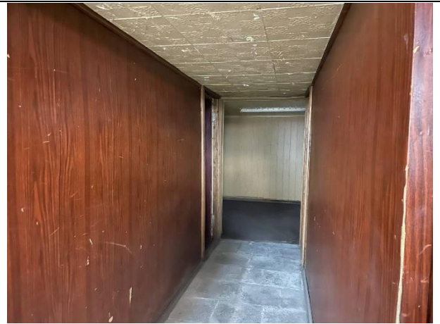
Фото № 20. Внутреннее состояние помещения
