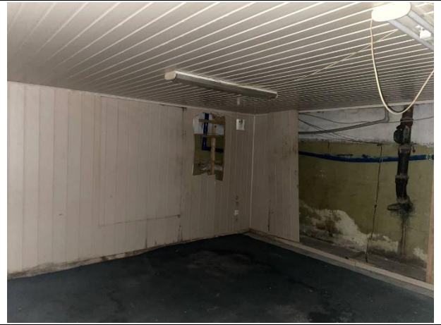
Фото № 8. Внутреннее состояние помещения
