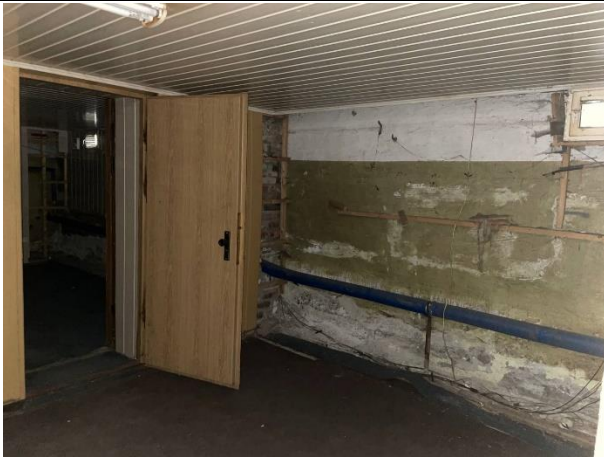
Фото № 17. Внутреннее состояние помещения
