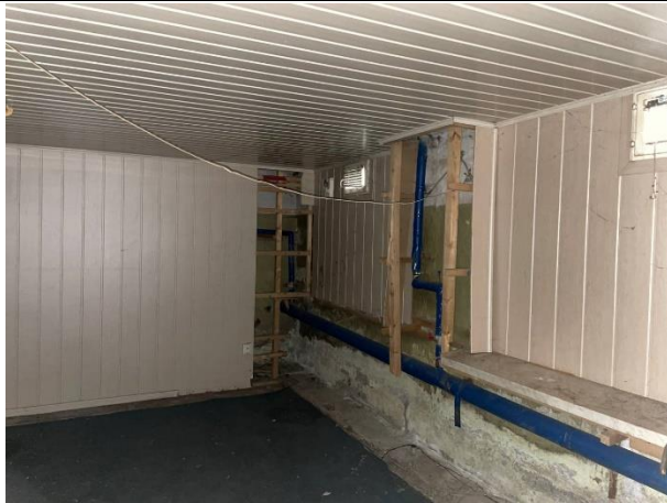
Фото № 9. Внутреннее состояние помещения
