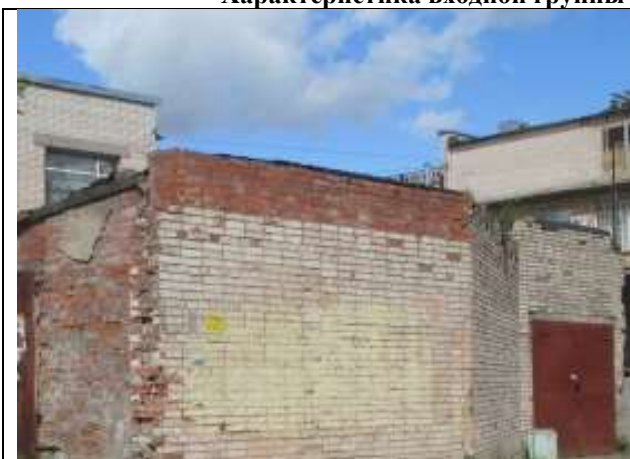
Фото 3. Вид здания, в котором расположен Объект оценки
