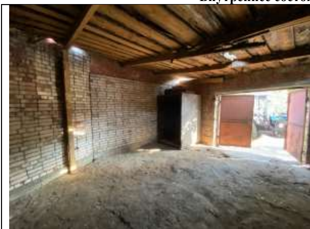
Фото 5. Внутреннее состояние Объекта оценки
