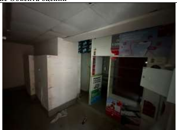
Фото 8. Внутреннее состояние Объекта оценки
