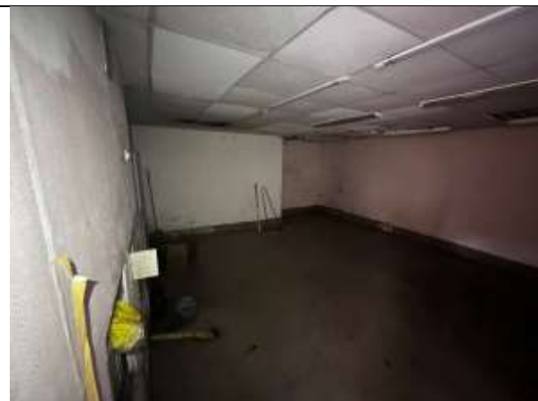
Фото 12. Внутреннее состояние Объекта оценки
