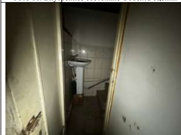
Фото 13. Внутреннее состояние Объекта оценки
