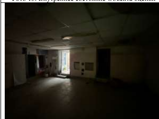
Фото 15. Внутреннее состояние Объекта оценки
