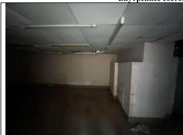
Фото 7. Внутреннее состояние Объекта оценки
