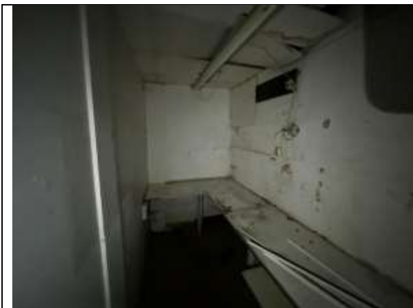
Фото 11. Внутреннее состояние Объекта оценки
