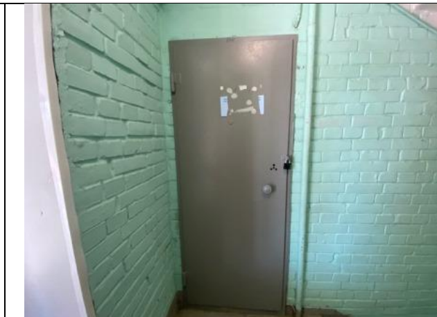
Фото № 6 – Вход в помещение
