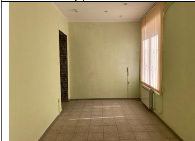
Фото № 15 – Внутреннее состояние помещения
