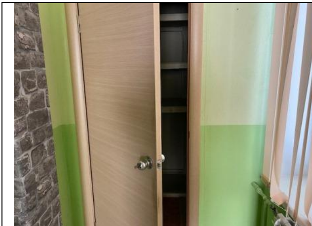
Фото № 13 – Внутреннее состояние помещения
