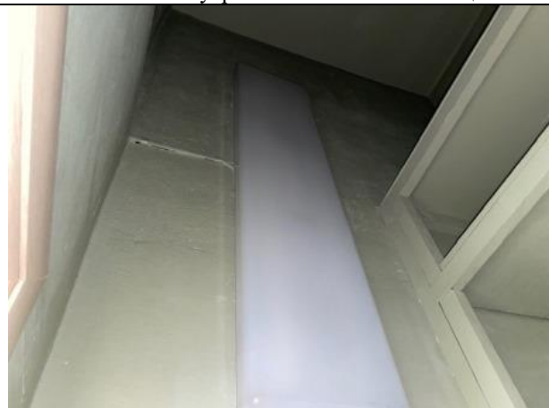
Фото № 16 – Внутреннее состояние помещения
