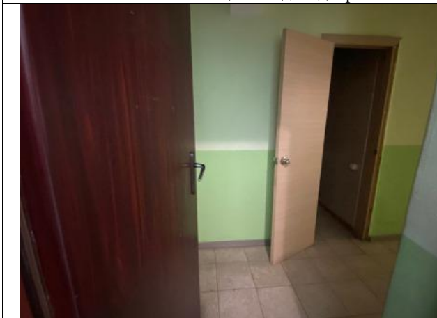
Фото № 7 – Внутреннее состояние помещения
