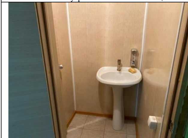
Фото № 9 – Внутреннее состояние помещения
