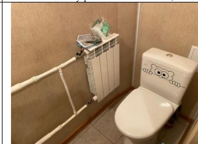
Фото № 10 – Внутреннее состояние помещения
