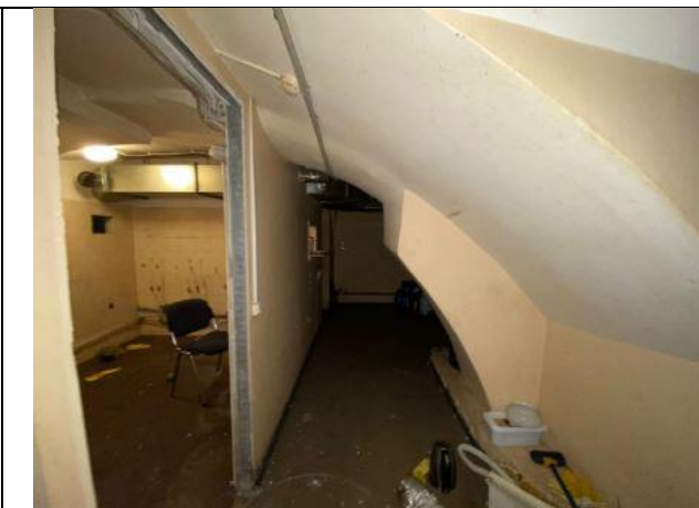
Фото № 28 – Внутреннее состояние помещения
