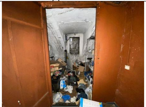
Фото № 16 – Внутреннее состояние помещения
