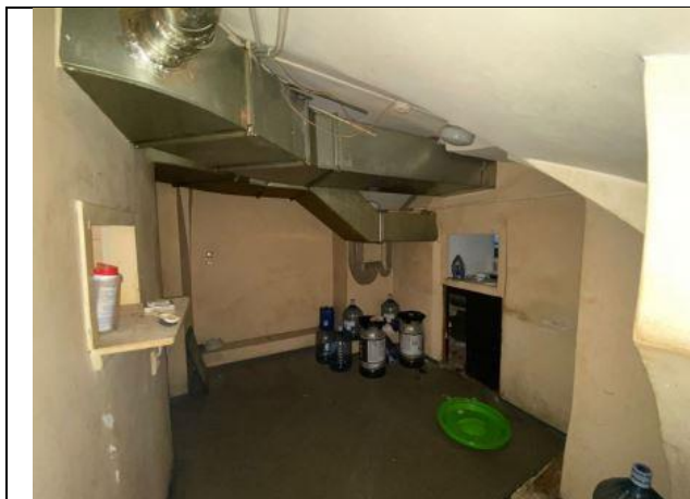
Фото № 27 – Внутреннее состояние помещения
