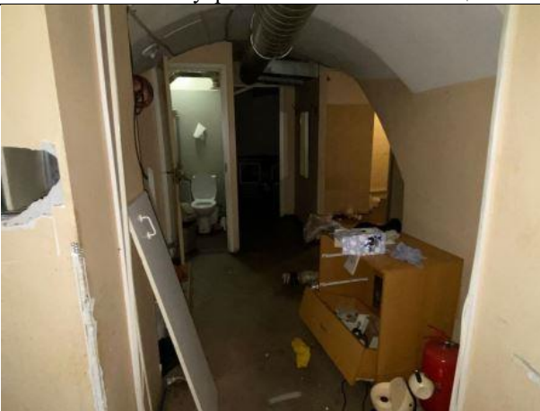
Фото № 23 – Внутреннее состояние помещения
