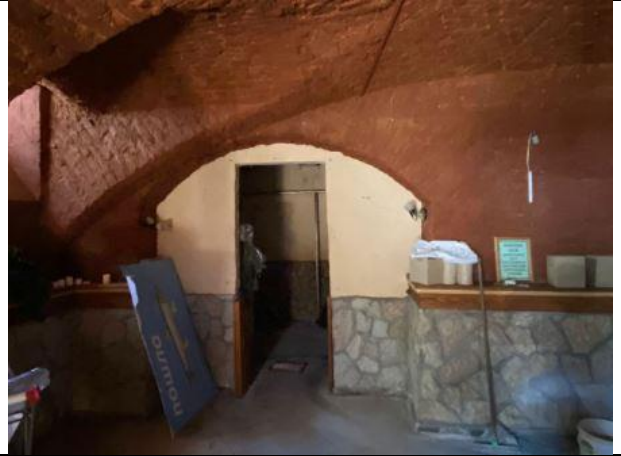
Фото № 12 – Внутреннее состояние помещения
