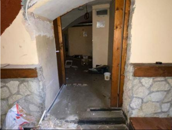
Фото № 19 – Внутреннее состояние помещения
