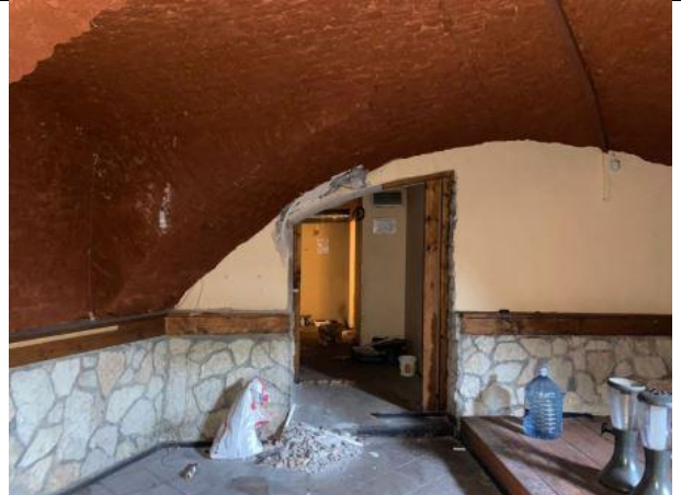
Фото № 14 – Внутреннее состояние помещения
