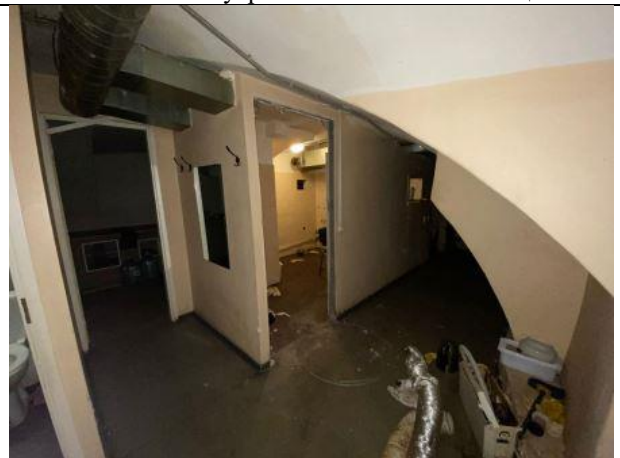
Фото № 24 – Внутреннее состояние помещения
