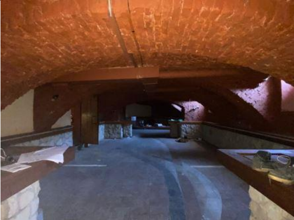
Фото № 13 – Внутреннее состояние помещения
