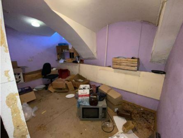
Фото № 21 – Внутреннее состояние помещения
