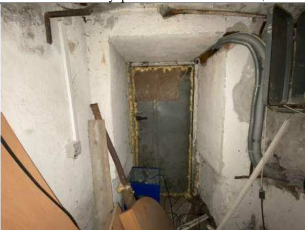
Фото № 17 – Внутреннее состояние помещения
