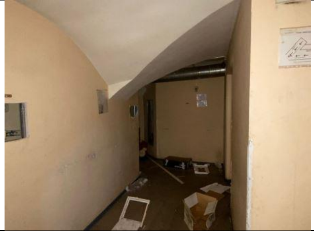
Фото № 20 – Внутреннее состояние помещения
