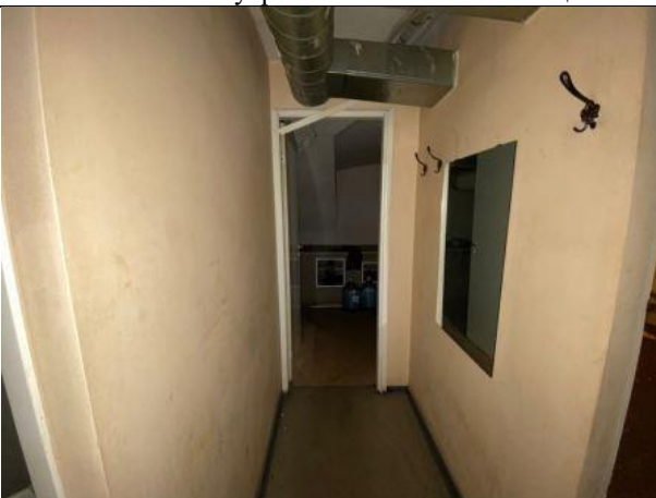
Фото № 25 – Внутреннее состояние помещения
