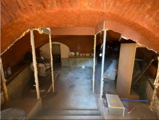
Фото № 11 – Внутреннее состояние помещения
