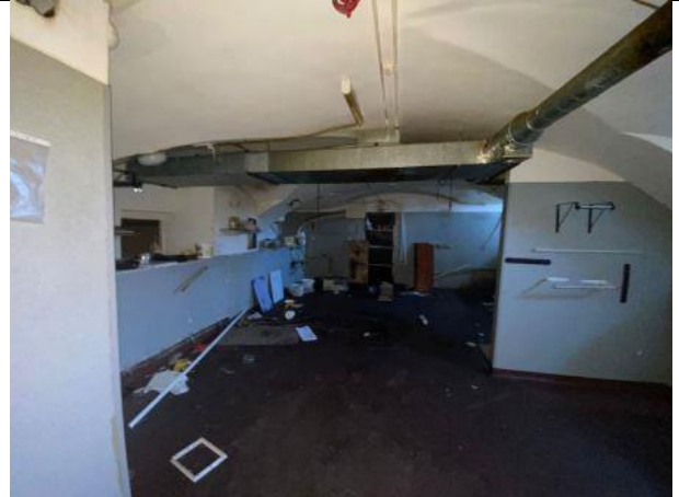
Фото № 22 – Внутреннее состояние помещения
