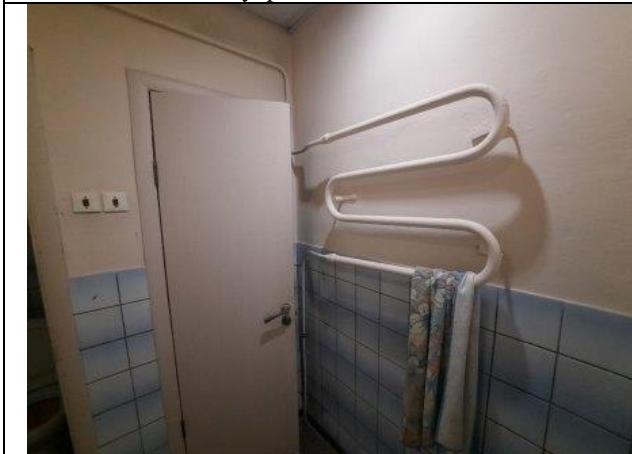
Фото № 33 – Внутреннее состояние помещения
