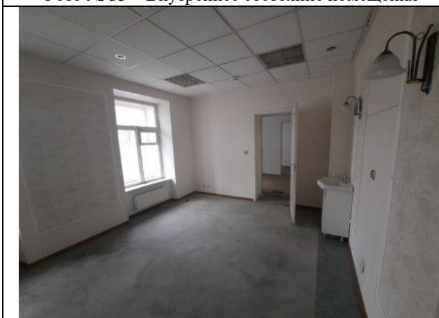
Фото № 37 – Внутреннее состояние помещения
