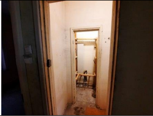
Фото № 25 – Внутреннее состояние помещения
