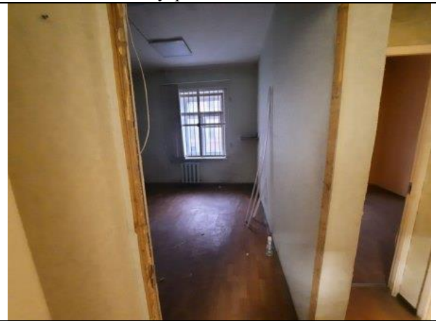
Фото № 28 – Внутреннее состояние помещения
