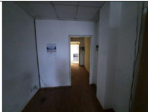
Фото № 40 – Внутреннее состояние помещения
