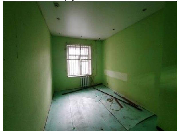
Фото № 20 – Внутреннее состояние помещения
