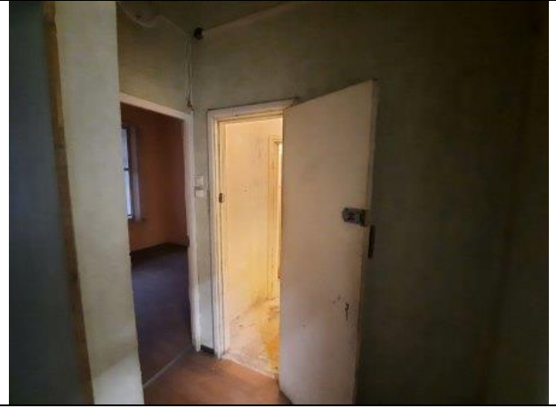
Фото № 24 – Внутреннее состояние помещения
