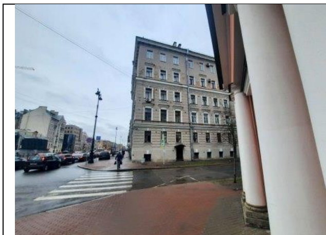
Фото № 1 – Подъездные пути
