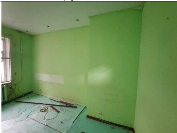
Фото № 19 – Внутреннее состояние помещения
