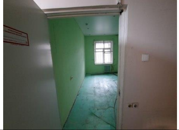
Фото № 18 – Внутреннее состояние помещения
