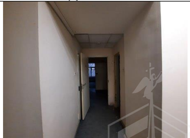
Фото № 30 – Внутреннее состояние помещения
