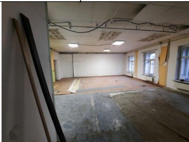
Фото № 9 – Внутреннее состояние помещения
