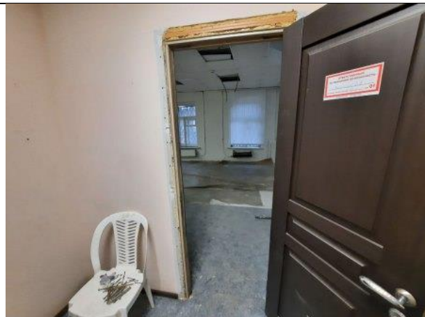
Фото № 8 – Внутреннее состояние помещения
