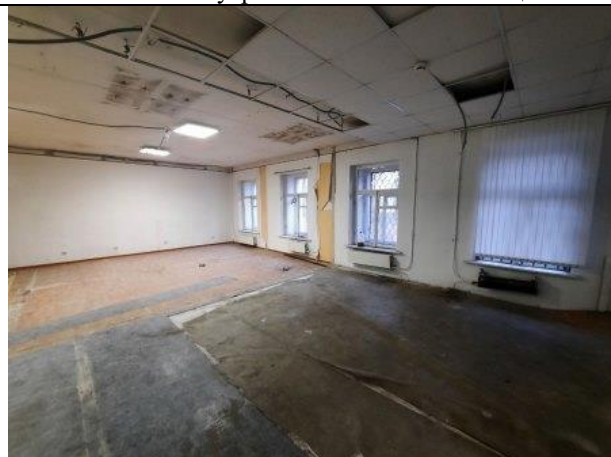
Фото № 10 – Внутреннее состояние помещения
