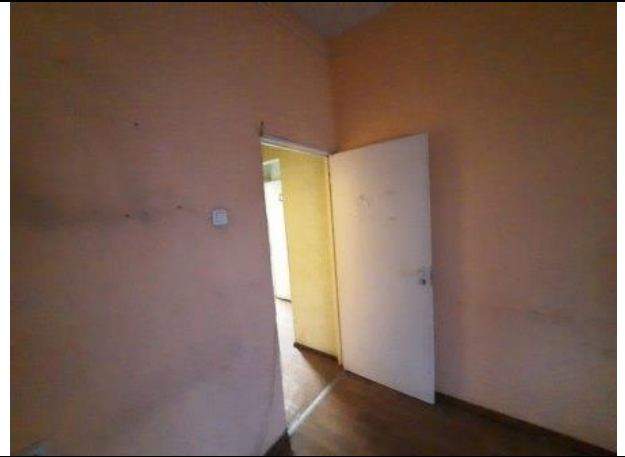
Фото № 26 – Внутреннее состояние помещения
