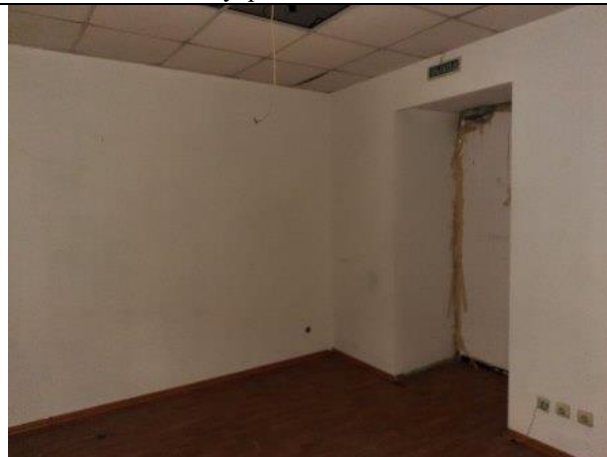
Фото № 44 – Внутреннее состояние помещения
