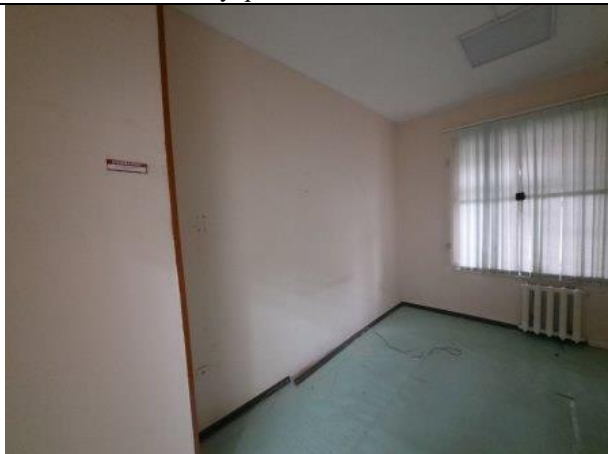
Фото № 21 – Внутреннее состояние помещения
