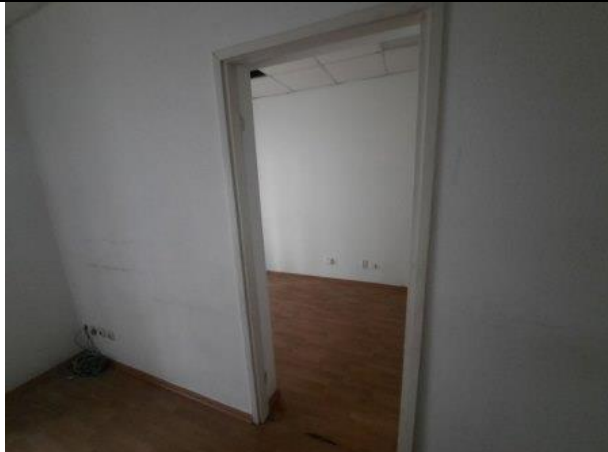
Фото № 41 – Внутреннее состояние помещения
