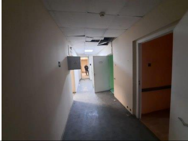
Фото № 17 – Внутреннее состояние помещения
