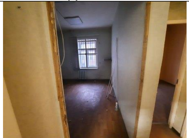
Фото № 28 – Внутреннее состояние помещения
