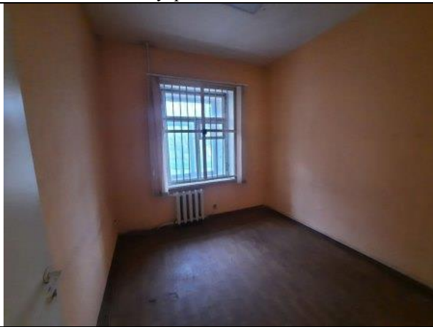
Фото № 27 – Внутреннее состояние помещения
