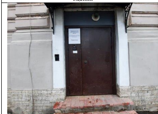
Фото № 5 – Общий вход с улицы
