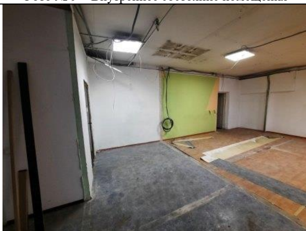
Фото № 11 – Внутреннее состояние помещения
