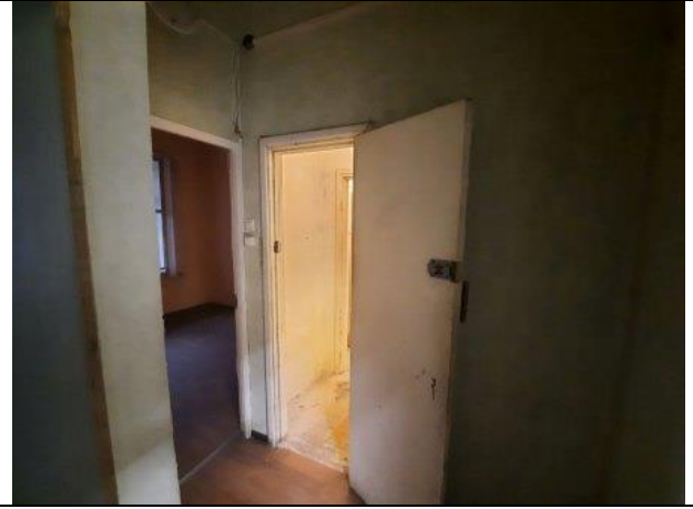
Фото № 24 – Внутреннее состояние помещения
