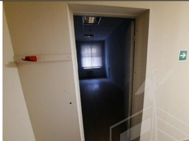
Фото № 46 – Внутреннее состояние помещения
