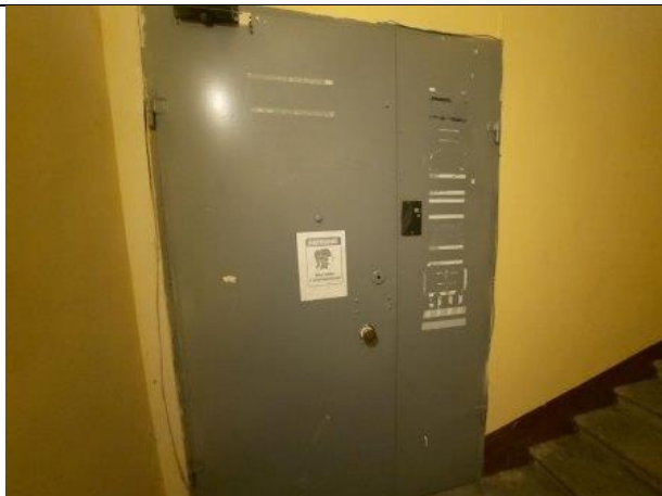
Фото № 7 – Первый вход в помещение
