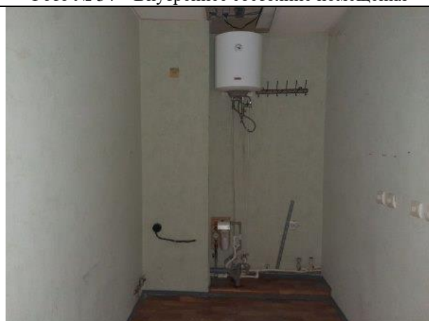
Фото № 36 – Внутреннее состояние помещения
