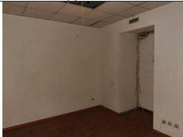
Фото № 44 – Внутреннее состояние помещения
