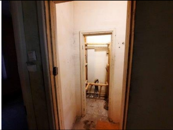
Фото № 25 – Внутреннее состояние помещения
