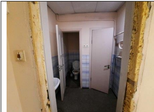
Фото № 31 – Внутреннее состояние помещения
