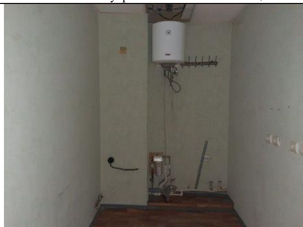
Фото № 36 – Внутреннее состояние помещения
