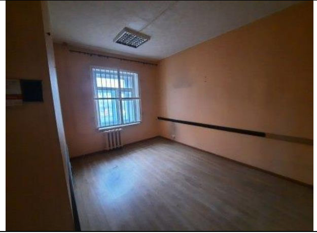
Фото № 16 – Внутреннее состояние помещения
