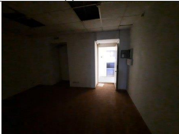
Фото № 43 – Внутреннее состояние помещения
