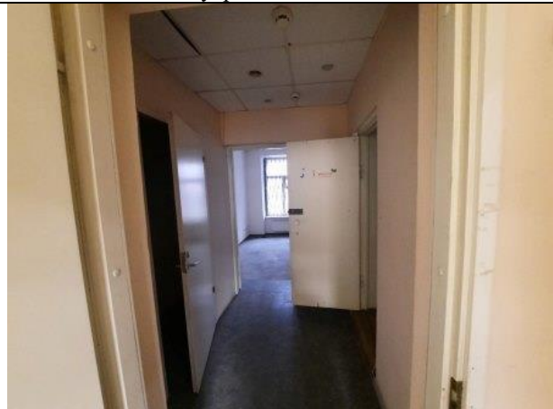
Фото № 34 – Внутреннее состояние помещения
