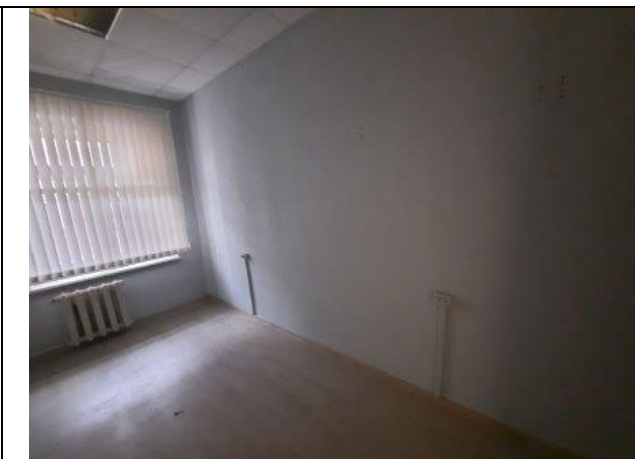
Фото № 48 – Внутреннее состояние помещения
