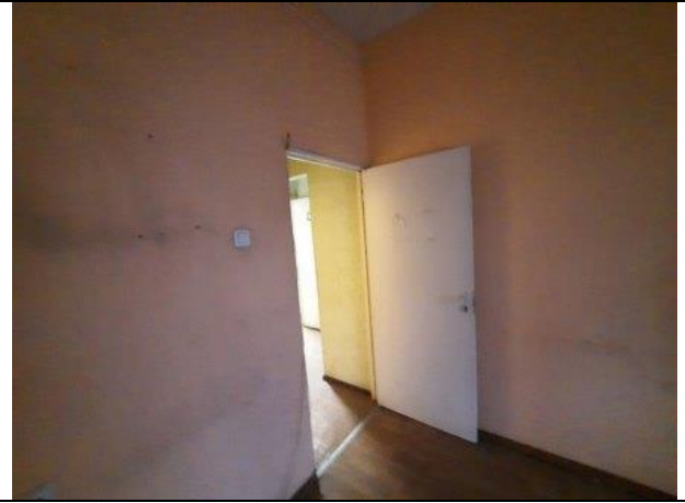
Фото № 26 – Внутреннее состояние помещения
