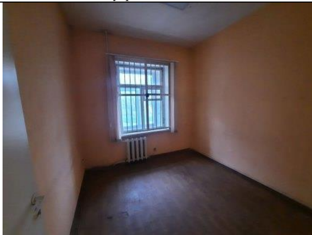
Фото № 27 – Внутреннее состояние помещения
