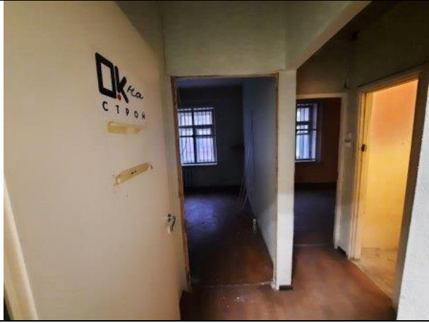
Фото № 23 – Внутреннее состояние помещения
