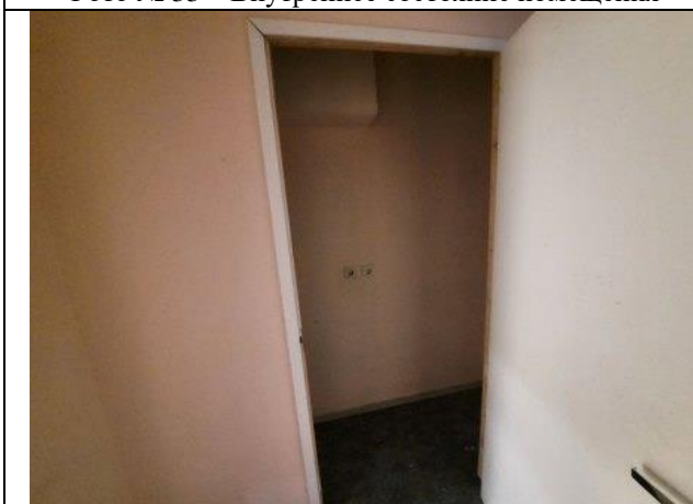
Фото № 35 – Внутреннее состояние помещения
