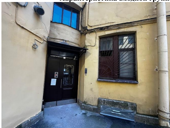
Фото 5. Общий вход со двора
