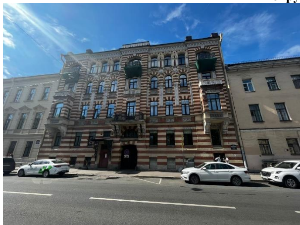
Фото 1. Вид здания, в котором расположен Объект оценки
