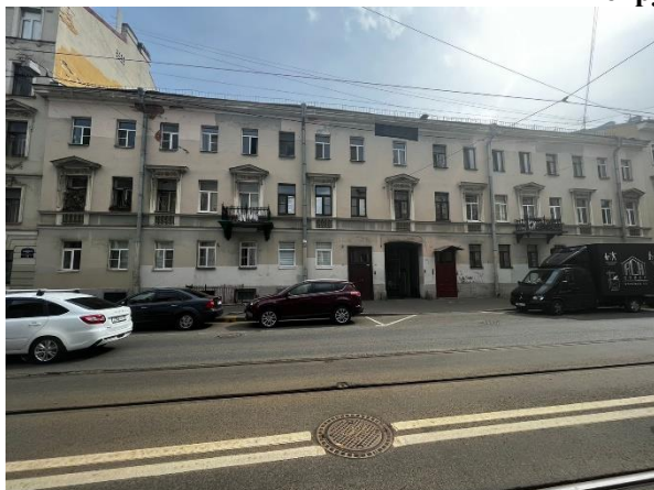
Фото 1. Вид здания, в котором расположен Объект оценки
