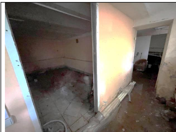
Фото 33. Типичное состояние Объекта оценки
