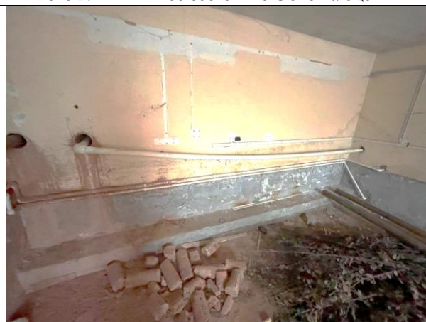
Фото 31. Типичное состояние Объекта оценки
