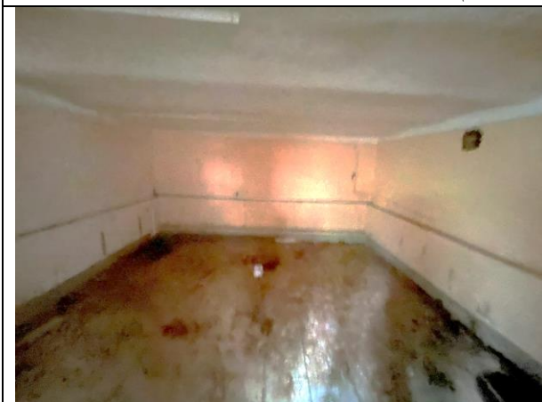
Фото 35. Типичное состояние Объекта оценки
