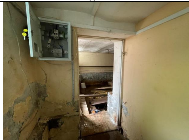
Фото 28. Типичное состояние Объекта оценки
