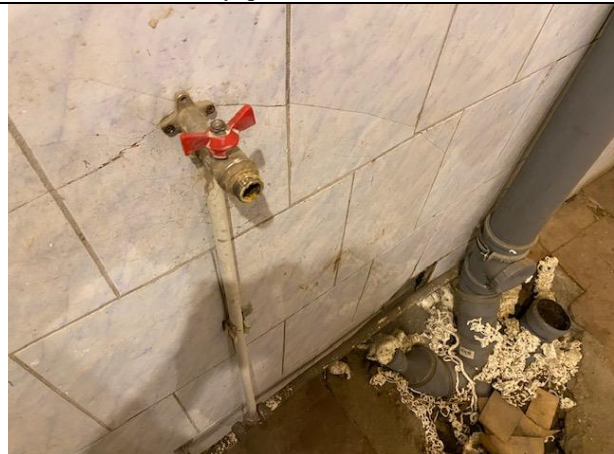
Фото № 14 – Внутреннее состояние помещения
