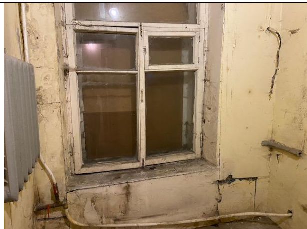
Фото № 20 – Внутреннее состояние помещения
