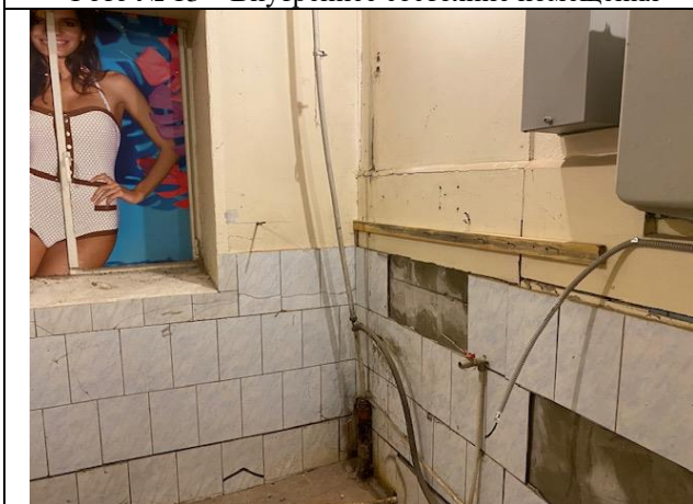
Фото № 15 – Внутреннее состояние помещения
