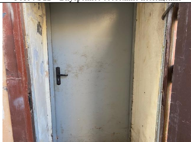
Фото № 24 – Внутреннее состояние помещения
