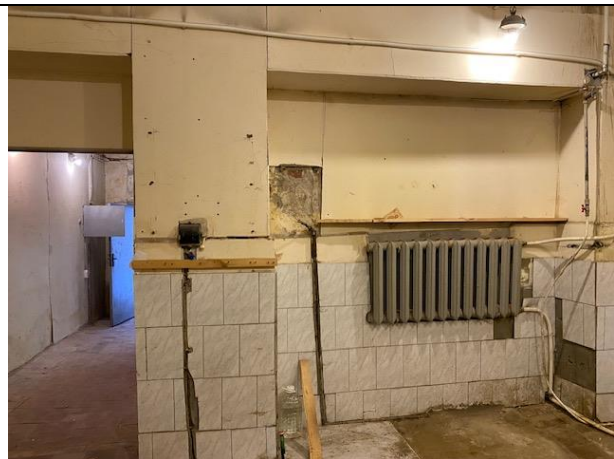
Фото № 12 – Внутреннее состояние помещения
