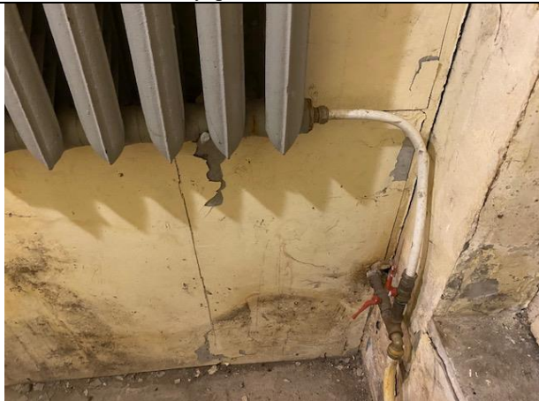
Фото № 21 – Внутреннее состояние помещения
