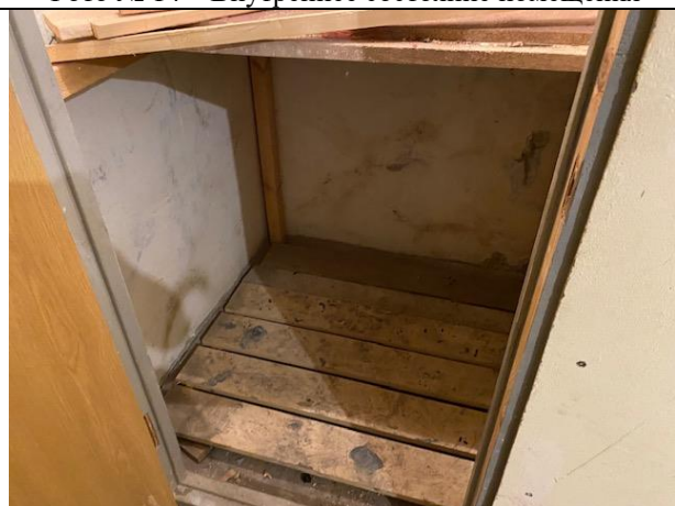
Фото № 16 – Внутреннее состояние помещения
