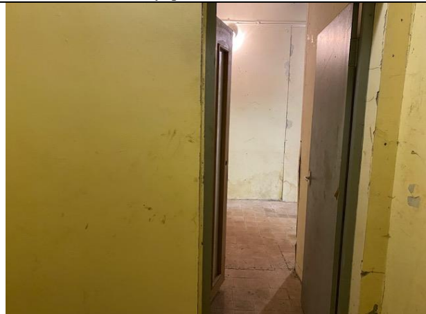
Фото № 22 – Внутреннее состояние помещения
