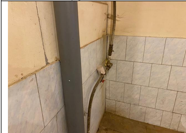
Фото № 13 – Внутреннее состояние помещения
