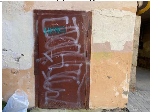
Фото № 6 – Вход в помещение со двора
