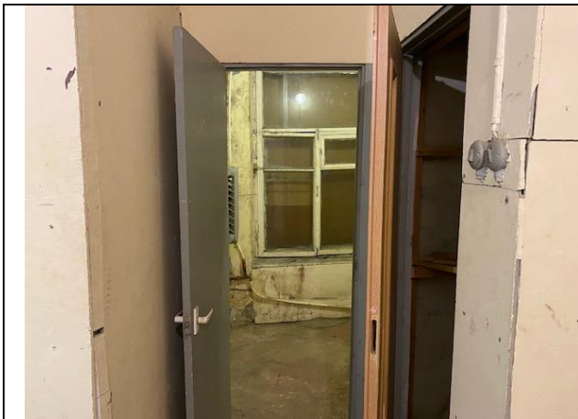
Фото № 19 – Внутреннее состояние помещения
