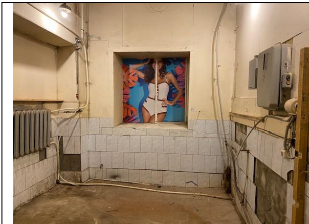
Фото № 11 – Внутреннее состояние помещения
