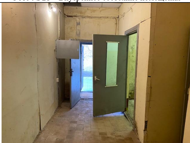
Фото № 23 – Внутреннее состояние помещения
