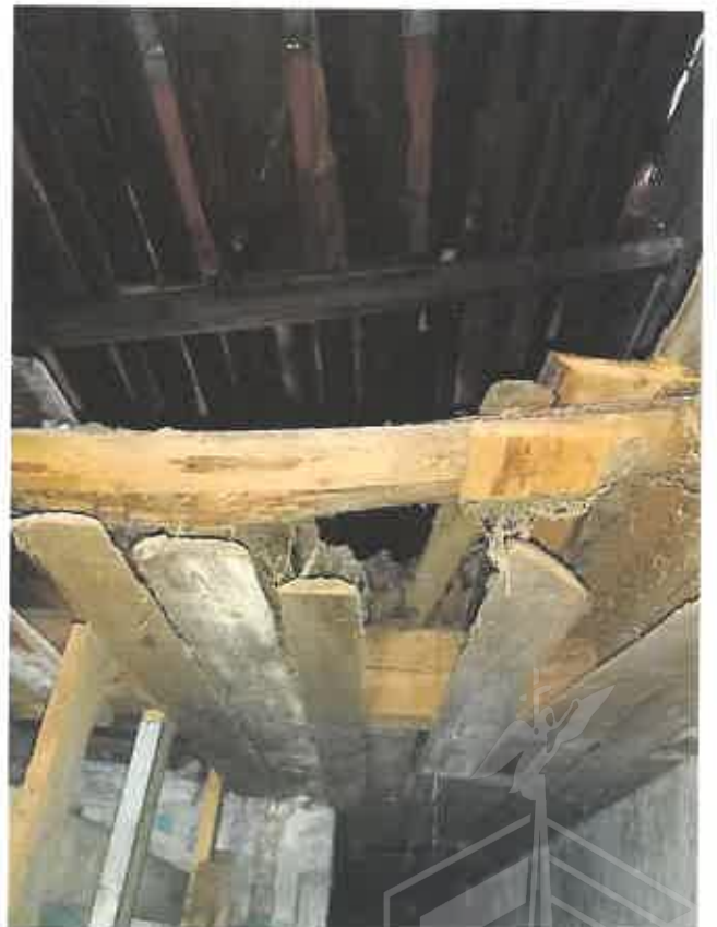
Фото 16. Ч.п.6 (конюшня) пом.1-Н
