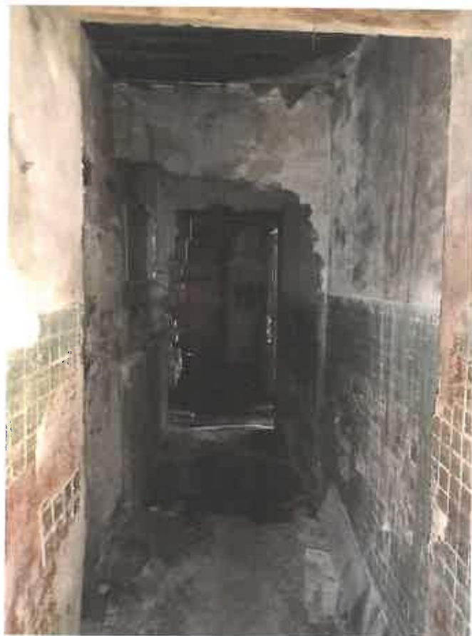
Фото 19. Ч.п.4 пом.1-Н (коридор)
