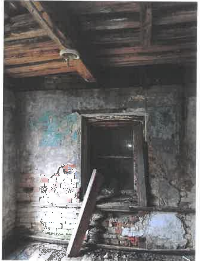
Фото 14. Ч.п.6 (конюшня) пом.1-Н
