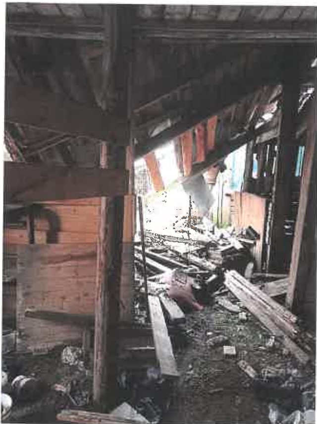
Фото 25. Ч.п.3 (конюшня) пом.1-Н
