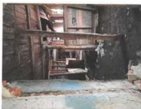
Фото 27. Ч.п.2 (коридор) дом. 1-Н
