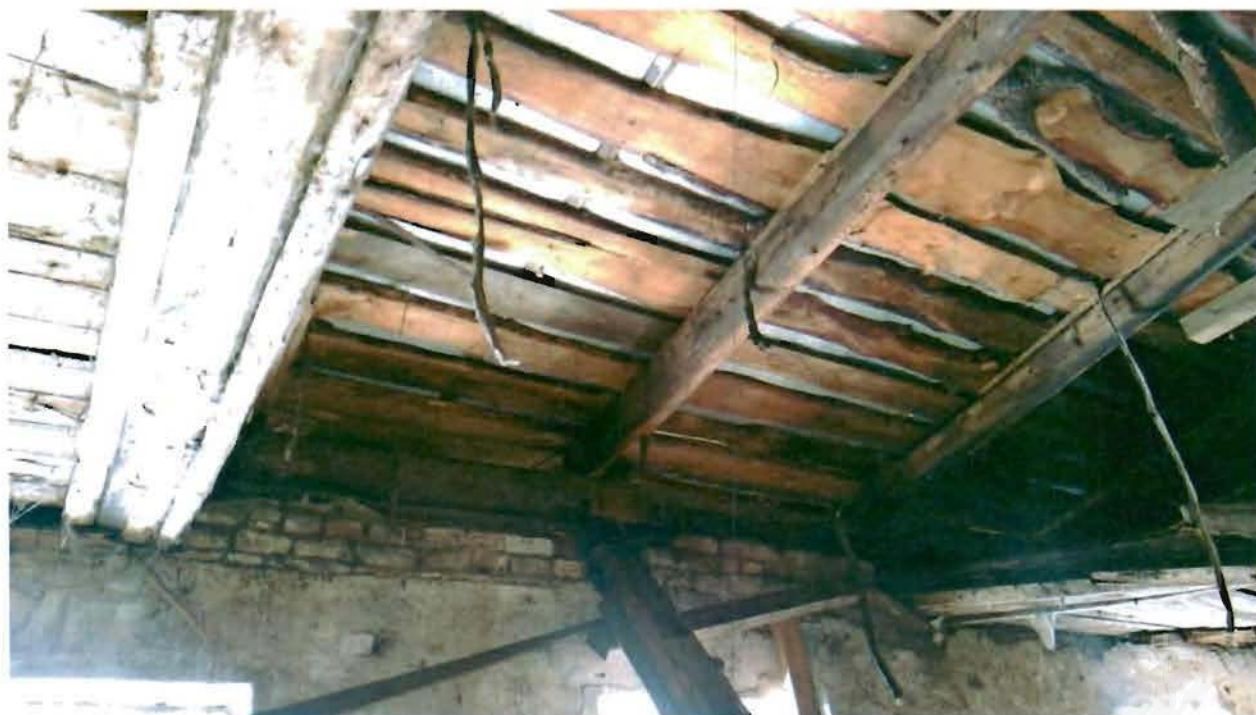
6. Стропильная система.
