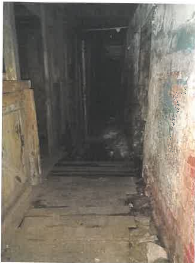
Фото 17. Ч.п.7 (конюшня) пом.1-Н
