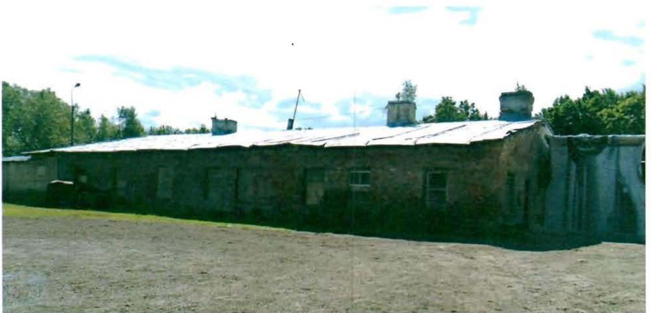
1. Общий вид с северо-запада.
