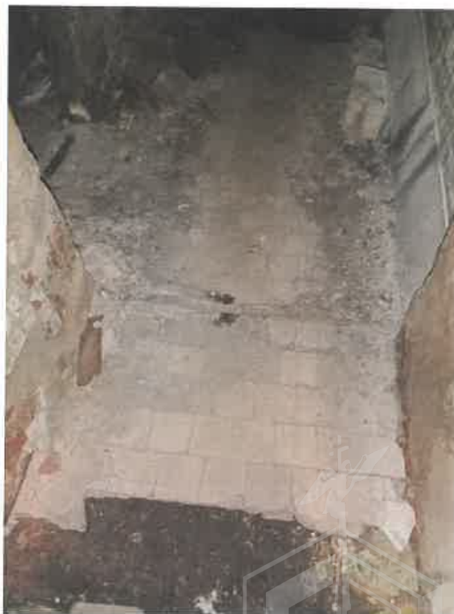
Фото 20. Ч.п.4 пом.1-Н (полы коридора)
