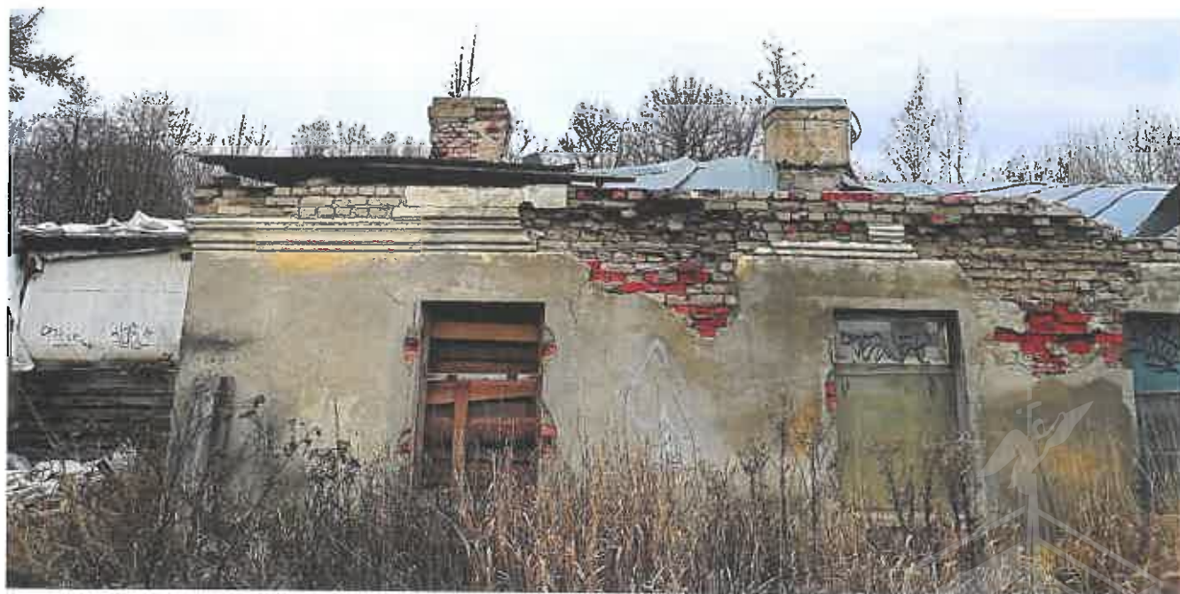
Фото 10. Левая часть южного фасада
