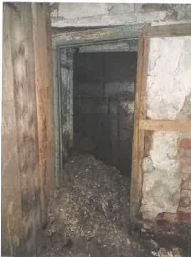
Фото 21. Ч.п.9 (конюшня) пом.1-Н (выход ч/з восточный фасад)
