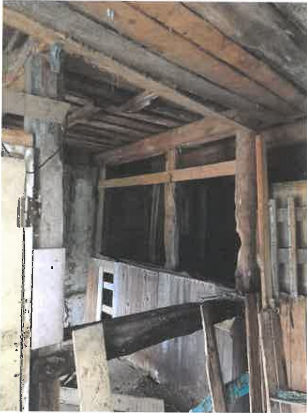
Фото 13. Ч.п.6 (конюшня) пом.1-Н
