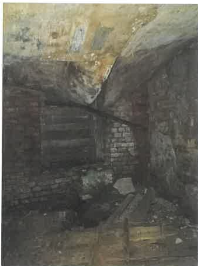
Фото 22. Ч.п.9 (конюшня) пом.1-Н
