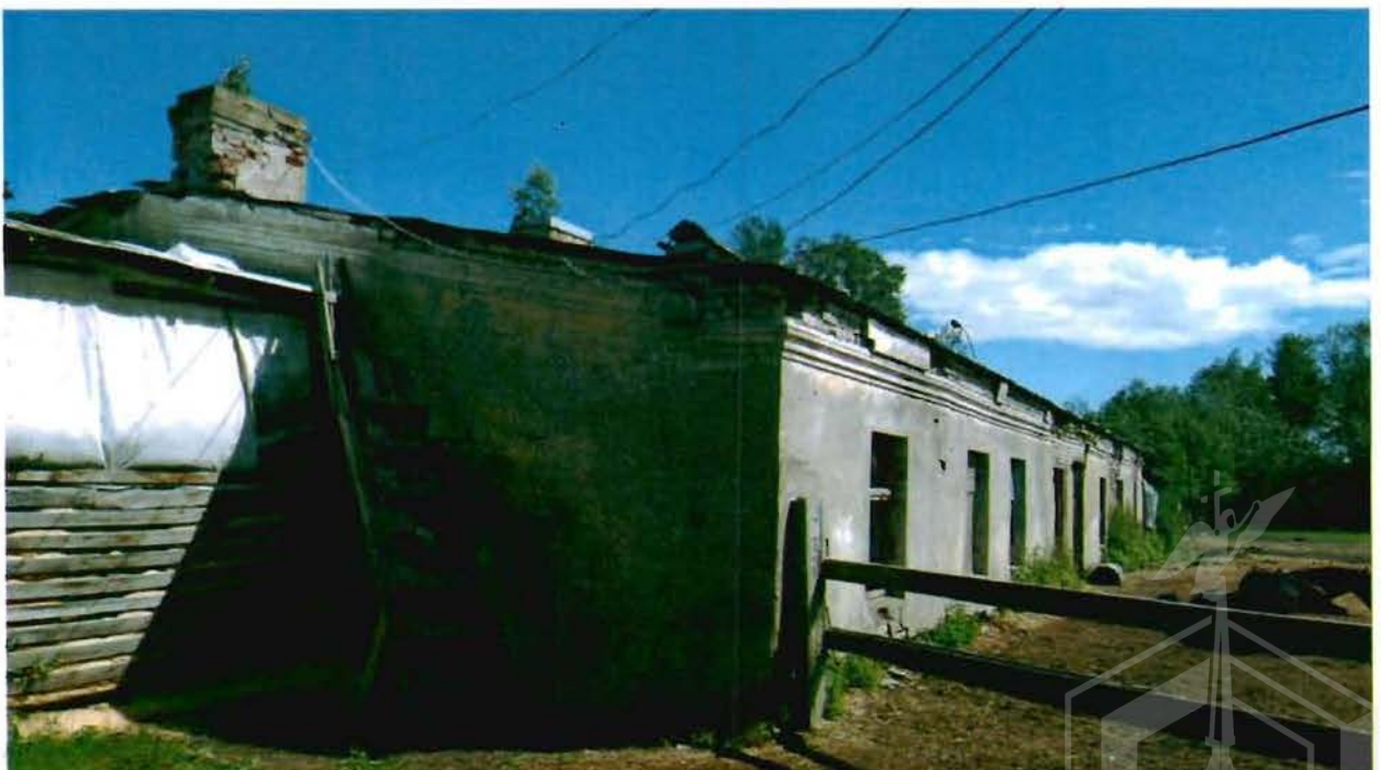
2. Вид с юго-запада.
