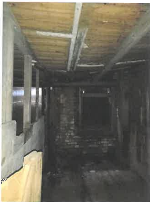
Фото 18. Ч.п.8 (конюшня) пом.1-Н
