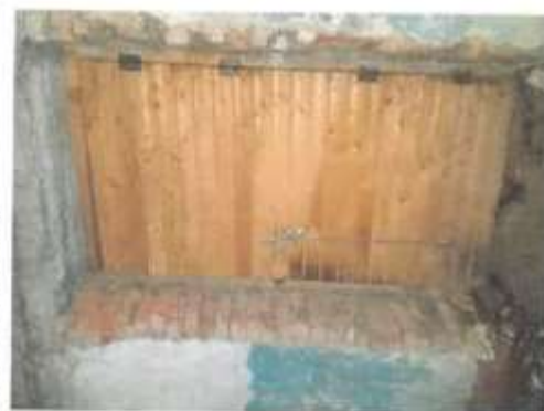
Фото 26. Ч.п.1 (тамбур) пом. 1-Н (выход через южный фасад)
