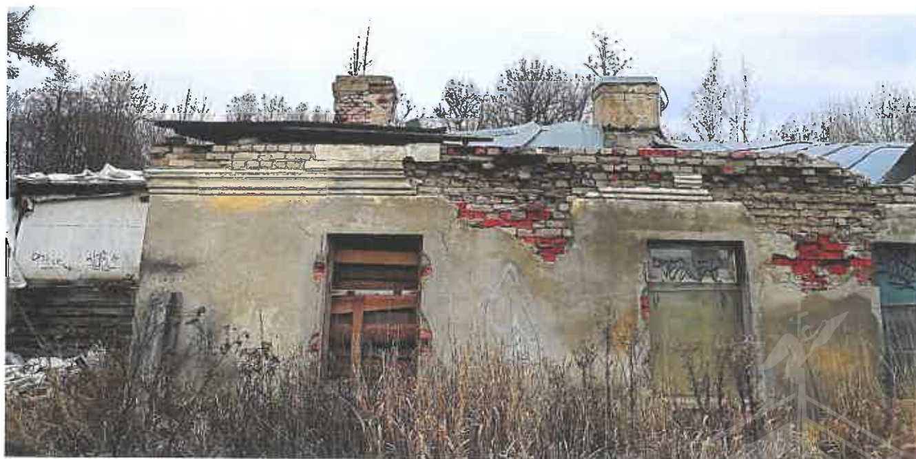
Фото 10. Левая часть южного фасада
