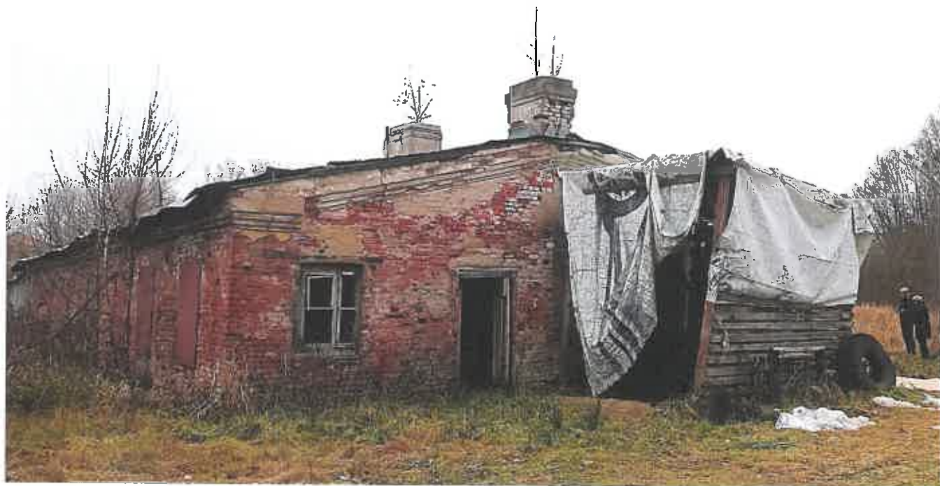
Фото 5. Угол северного и западного фасадов
