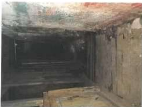
Фото 17. Ч.л.7 (комната) пом. 1-Н
