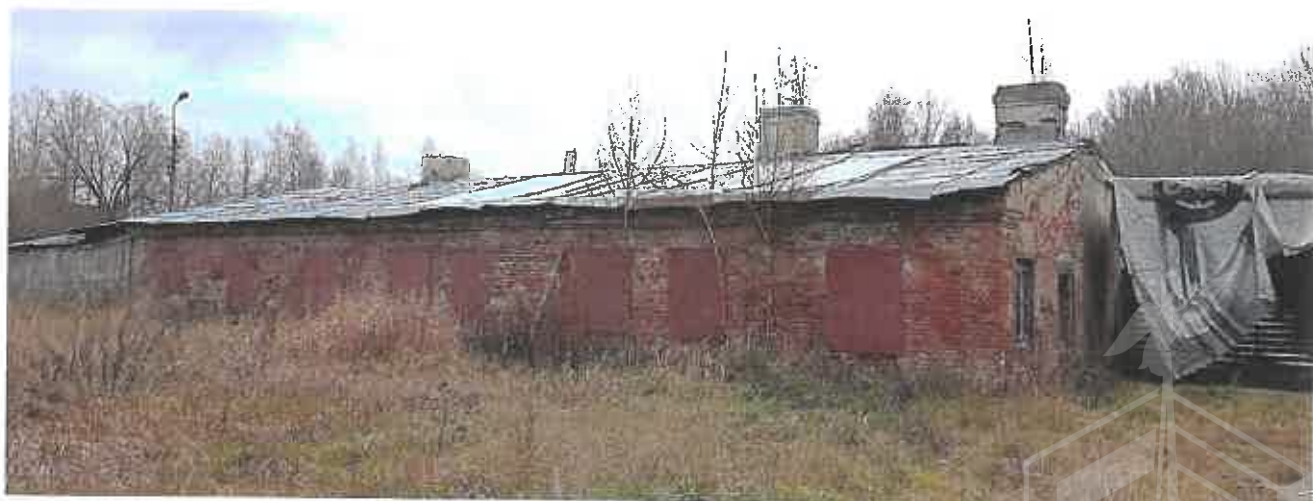
Фото 4. Фасады: северный и часть западного
