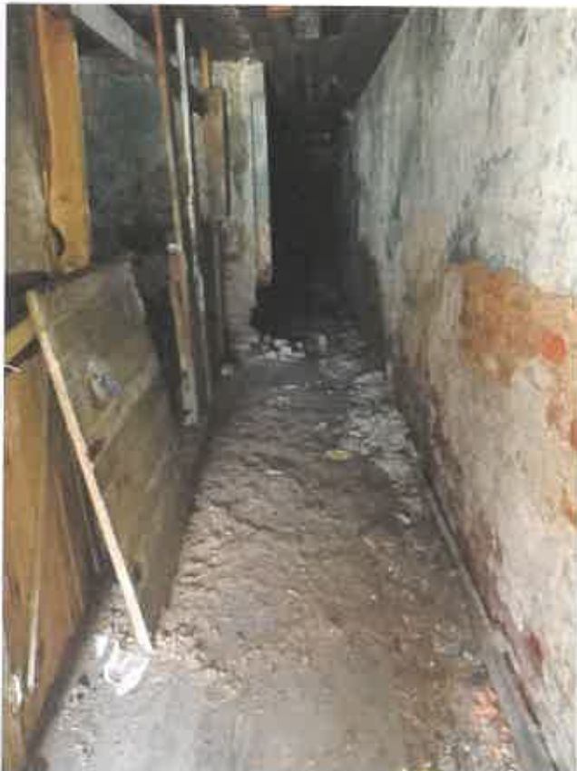
Фото 15. Ч.п.6 (конюшня) пом.1-Н
