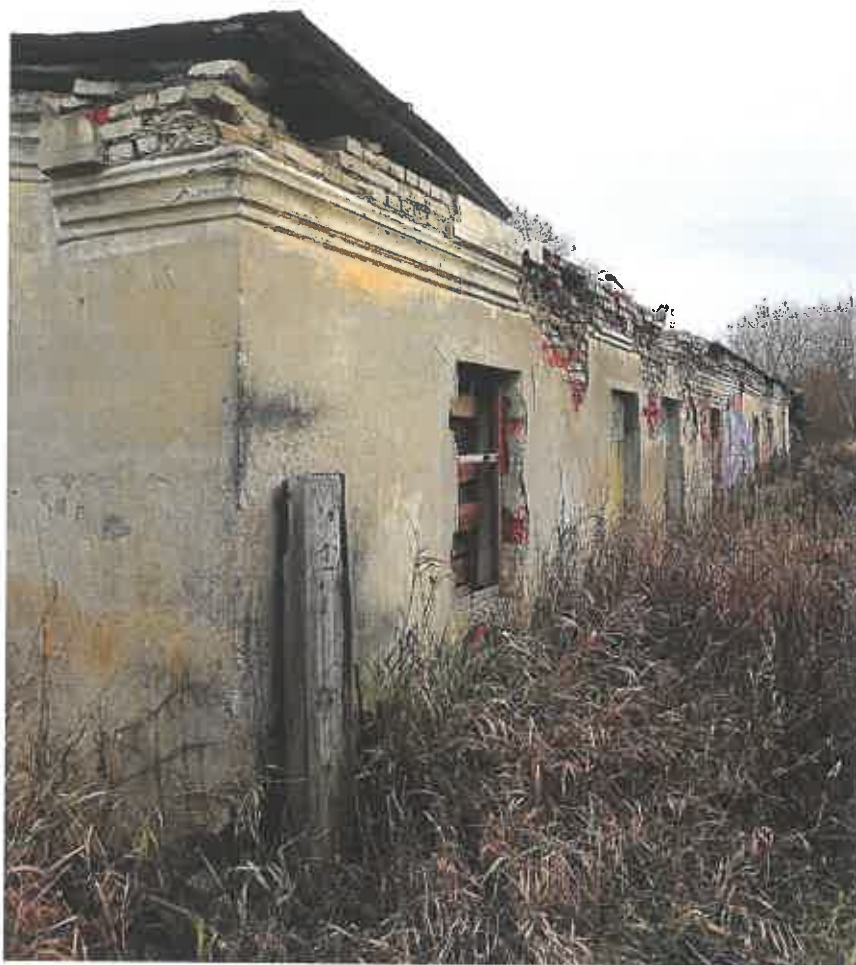
Фото 9. Угол западного и южного фасадов
