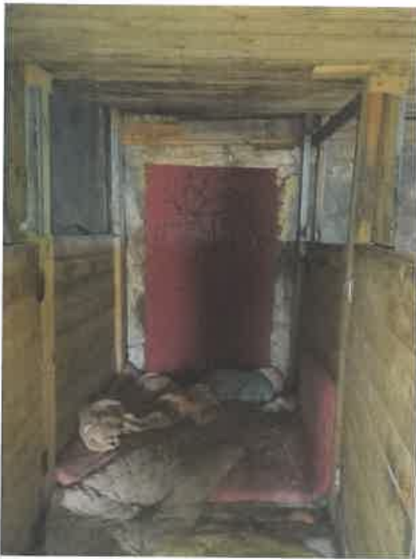
Фото 30. Вход в ч.п.9 (конюшня) пом.1-Н со стороны помещений самовольной деревянной пристройки к восточному фасаду Объекта
