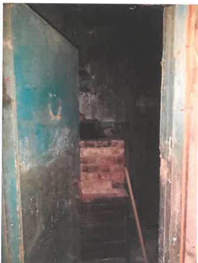
Фото 23. Вход в ч.п.5 (хоз.помещение) пом.1-Н
