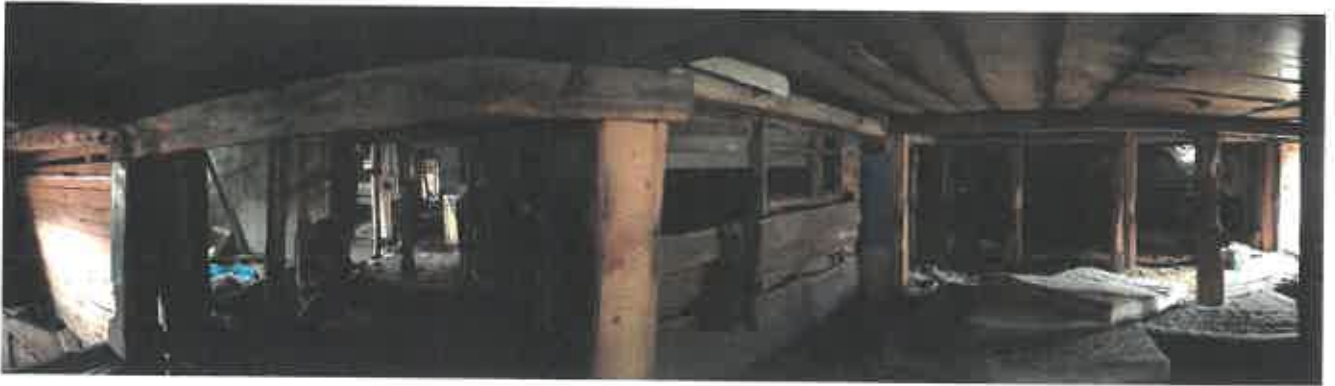
Фото 29. Панорамный снимок ч.п.2 (конюшня) пом.1-Н (в левой части снимка) и помещений самовольной деревянной пристройки к восточному фасаду Объекта
