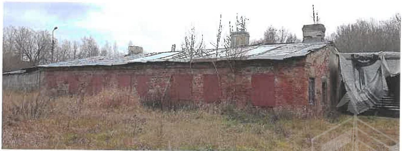
Фото 4. Фасады: северный и часть западного
