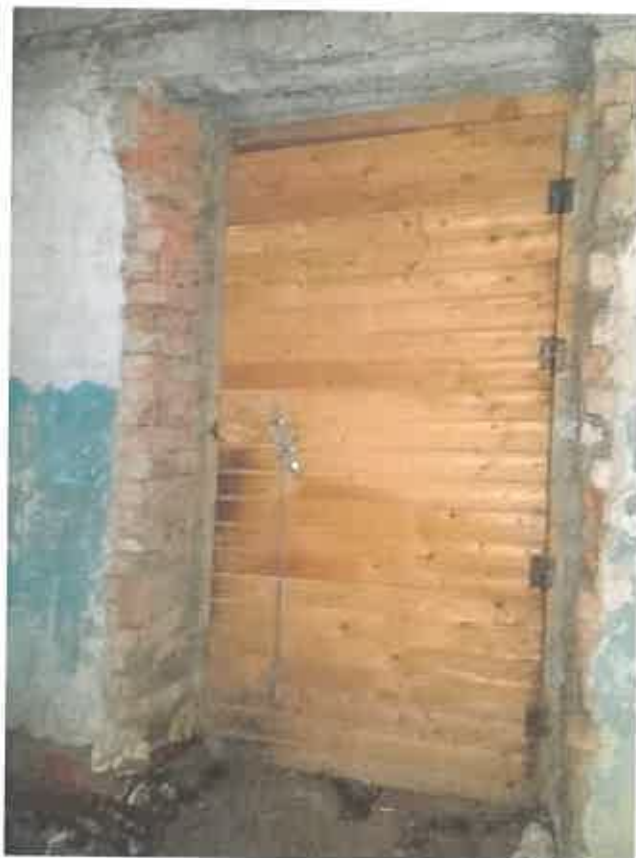
Фото 26. Ч.п.1 (тамбур) пом.1-Н (выход через южный фасад)
