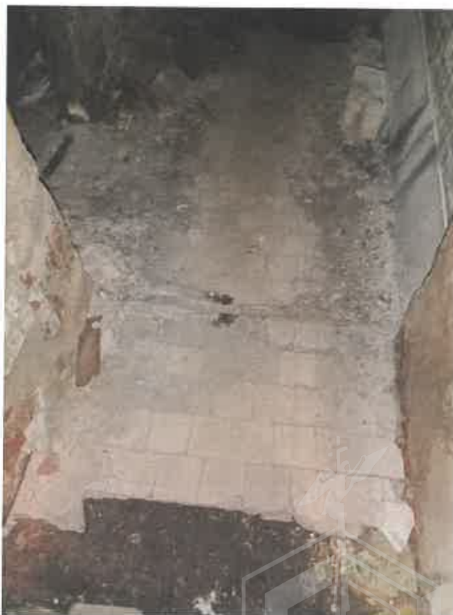
Фото 20. Ч.п.4 пом.1-Н (полы коридора)
