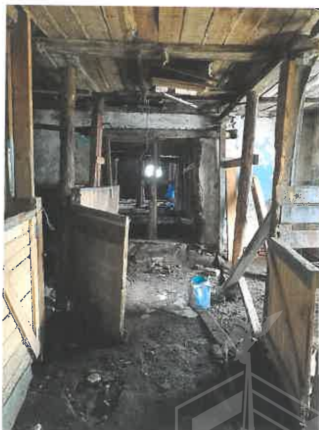
Фото 28. Ч.п.2 (конюшня) пом.1-Н
