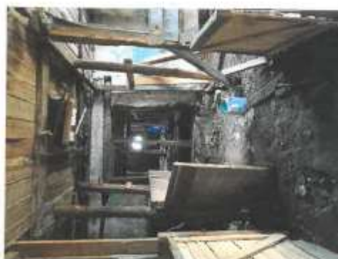
Фото 28. Ч.п.2 (кашпашка) пом. 1-Н
