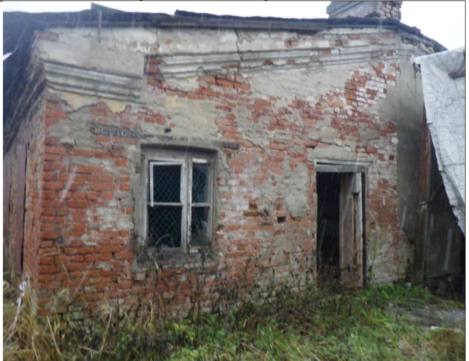
Описание: Вид на Объект
