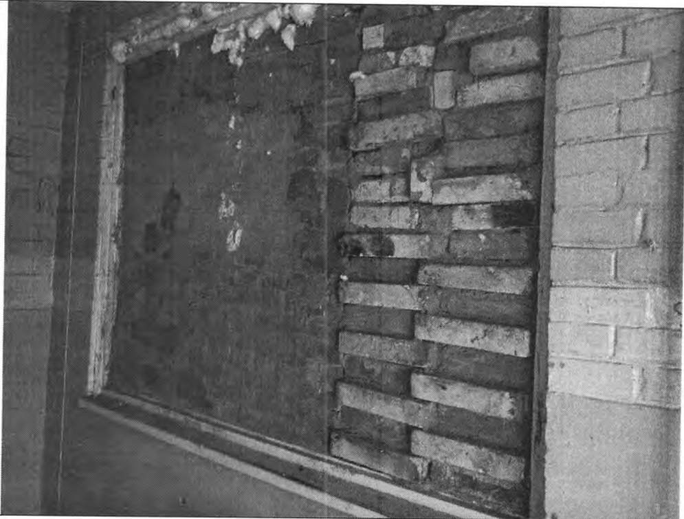
В ч.п. 2 Объекта заложен оконный проем.
