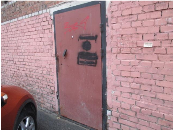
Фото № 9. Вход в здание
