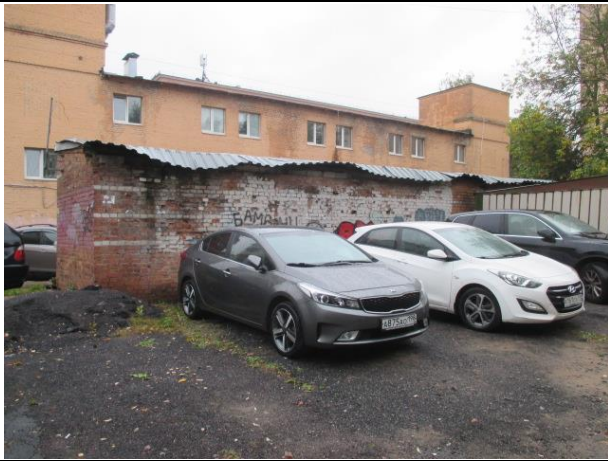
Фото № 7. Внешний вид здания
