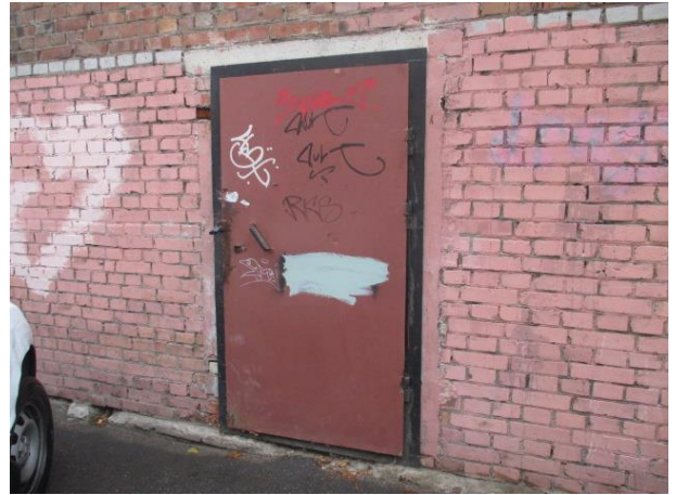
Фото № 10. Вход в здание
