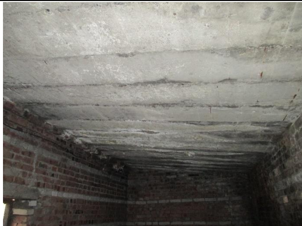
Фото № 13. Внутреннее состояние здания
