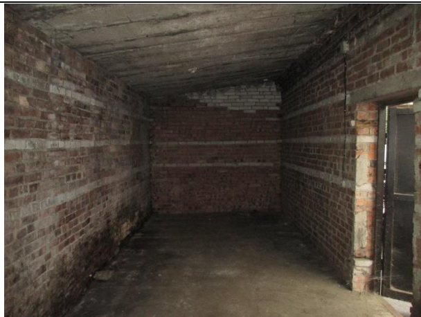
Фото № 11. Внутреннее состояние здания
