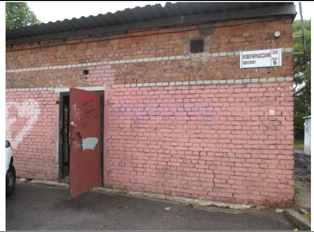
Фото № 8. Внешний вид здания
