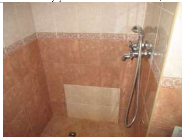
Фото 14. Внутреннее состояние Объекта оценки
