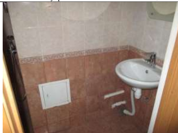
Фото 12. Внутреннее состояние Объекта оценки
