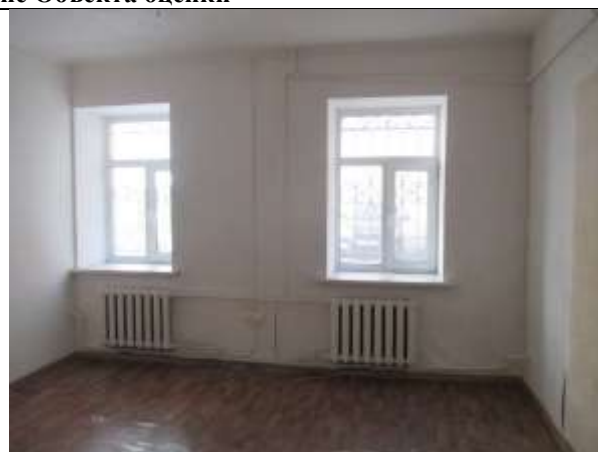
Фото 8. Внутреннее состояние Объекта оценки
