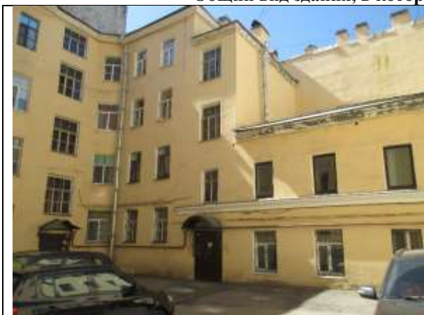
Фото 1. Вид здания, в котором расположен Объект оценки
