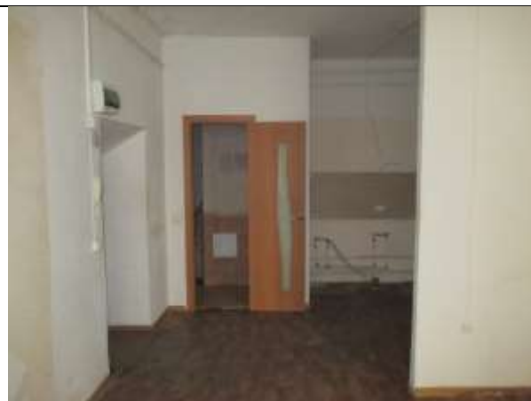
Фото 10. Внутреннее состояние Объекта оценки
