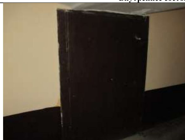
Фото 7. Внутреннее состояние Объекта оценки
