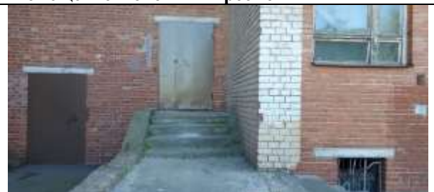
Фото 6. 1 общий вход со двора (закрыт)
