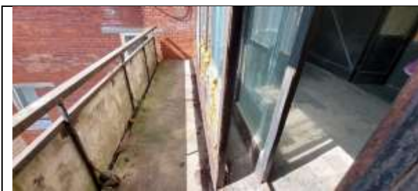
Фото 15. Внутреннее состояние Объекта оценки
