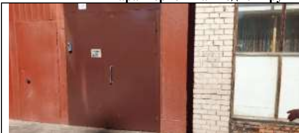
Фото 5. 1 общий вход с улицы
