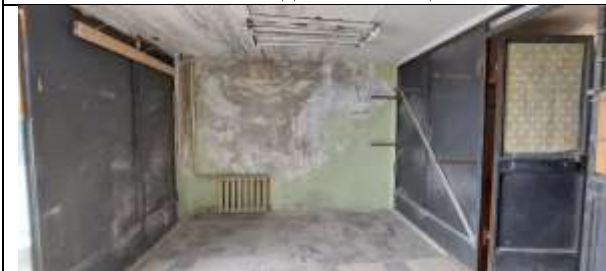
Фото 11. Внутреннее состояние Объекта оценки
