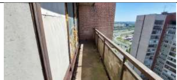
Фото 16. Внутреннее состояние Объекта оценки
