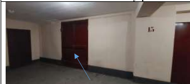
Фото 9. Вход Объекта оценки
