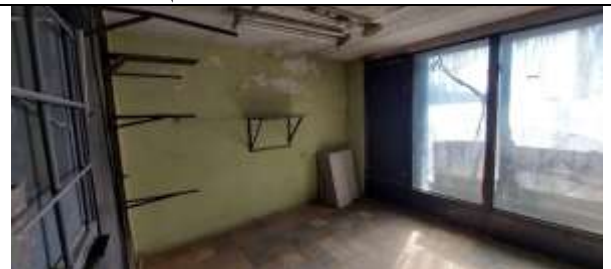
Фото 10. Внутреннее состояние Объекта оценки
