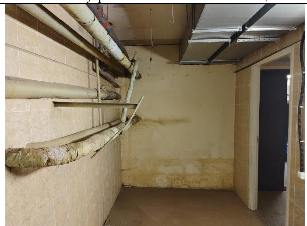
Фото 12. Внутреннее состояние Объекта оценки
