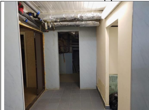
Фото 7. Внутреннее состояние Объекта оценки
