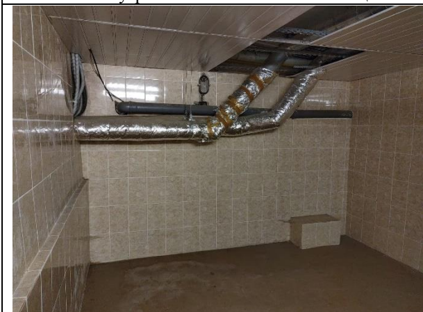
Фото 9. Внутреннее состояние Объекта оценки
