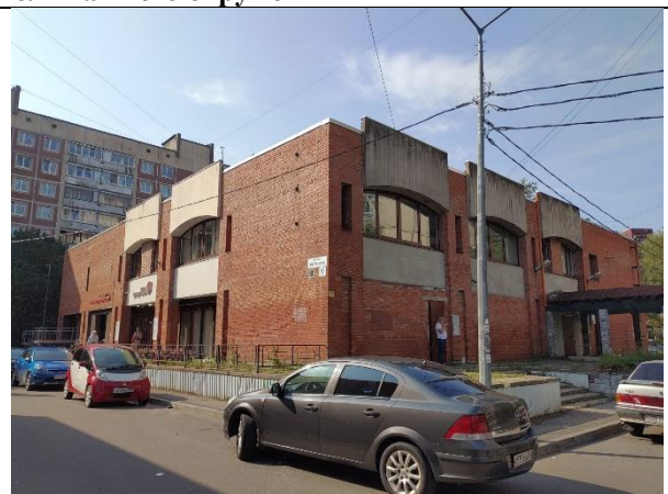
Фото 2. Вид здания, в котором расположен Объект оценки
