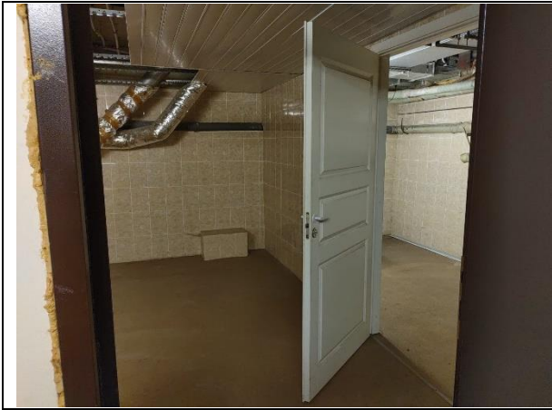
Фото 13. Внутреннее состояние Объекта оценки
