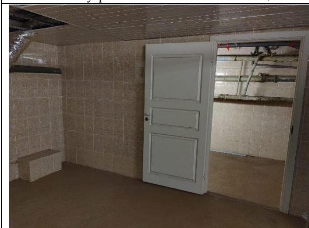
Фото 11. Внутреннее состояние Объекта оценки
