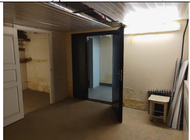
Фото 10. Внутреннее состояние Объекта оценки
