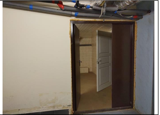
Фото 14. Внутреннее состояние Объекта оценки
