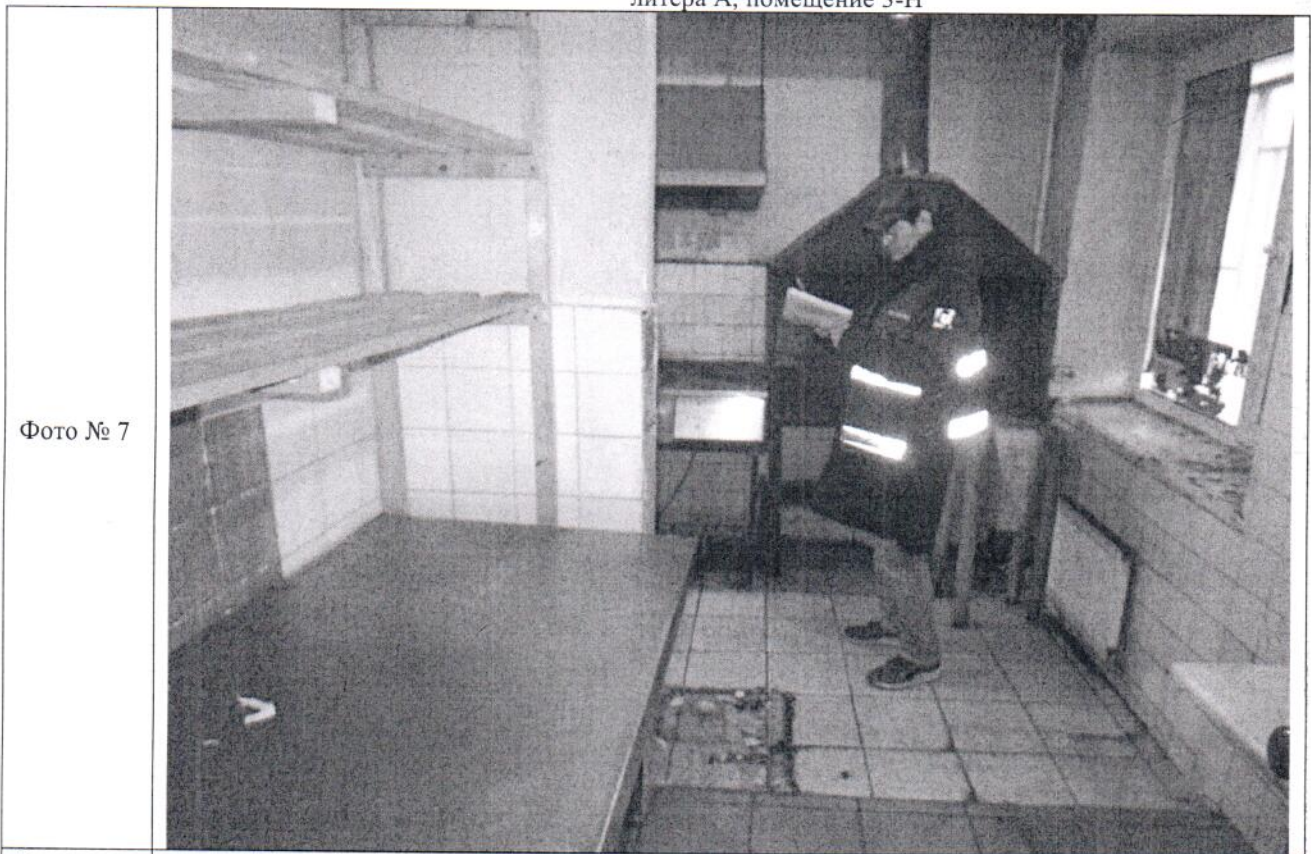
Описание: между ч.п. 6 и 7 Объекта демонтирована перегородка с дверным проемом
