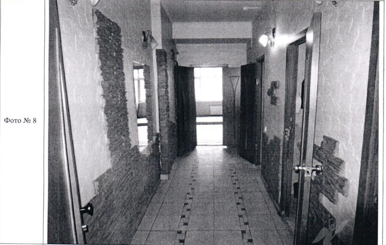
Описание: между ч.п. 9 и 10 Объекта демонтирована перегородка; в ч.п. 9 Объекта демонтировано сантехническое оборудование (раковины)
