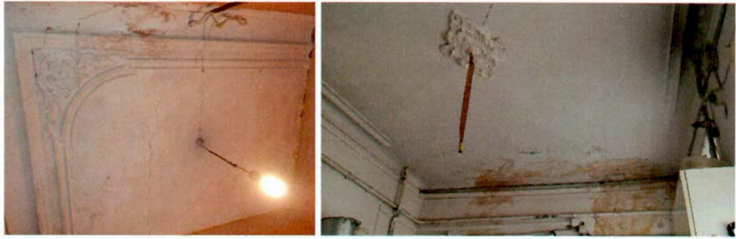
24, 25, 26. лестница Л-2 дворового корпуса
