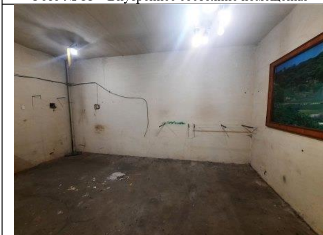
Фото № 13 – Внутреннее состояние помещения
