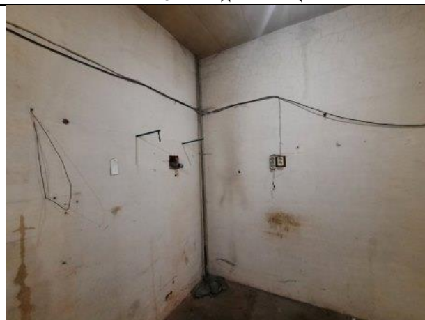
Фото № 10 – Внутреннее состояние помещения
