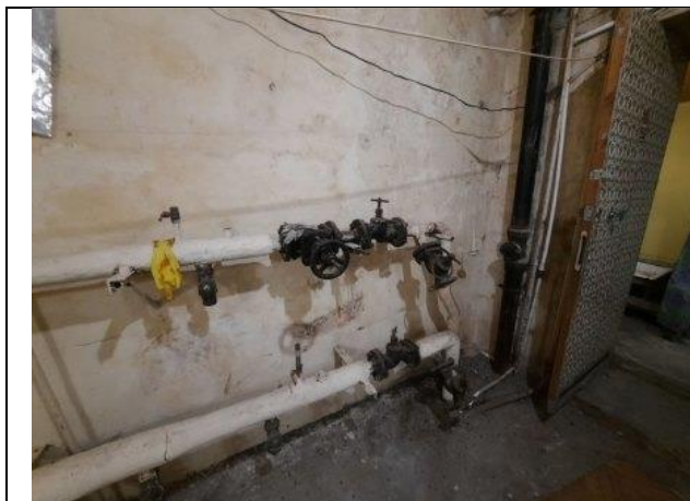
Фото № 15 – Внутреннее состояние помещения
