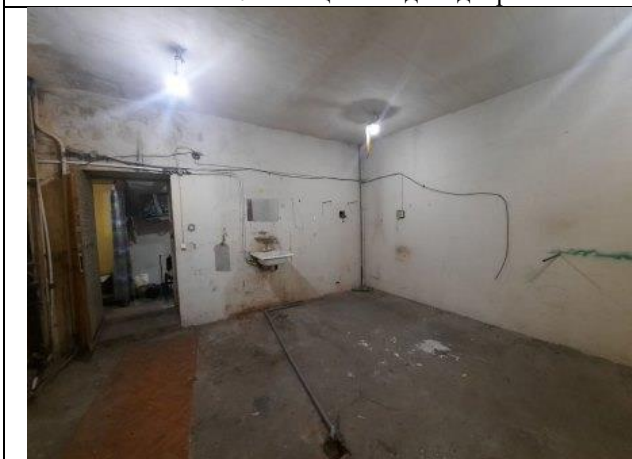
Фото № 9 – Внутреннее состояние помещения
