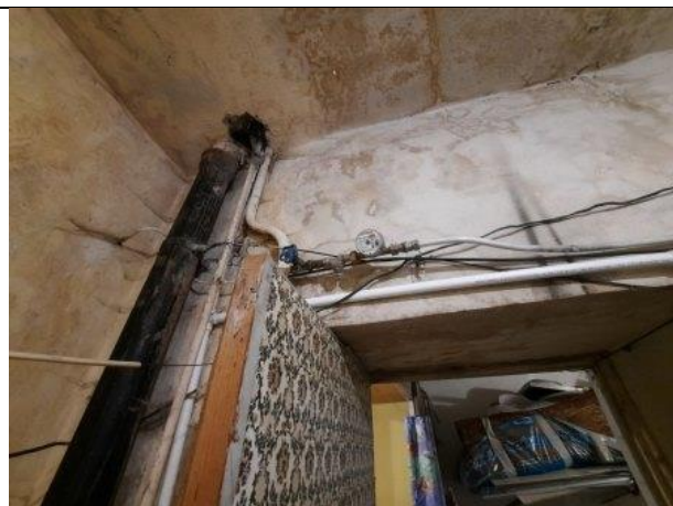
Фото № 16 – Внутреннее состояние помещения
