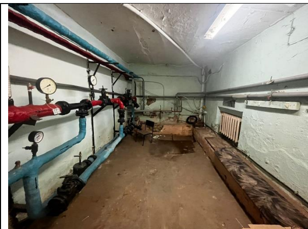
Фото 7. Внутреннее состояние Объекта оценки
