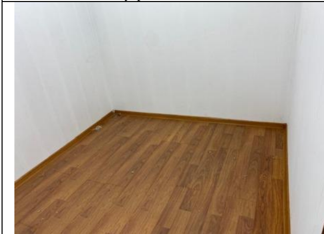
Фото № 23 – Внутреннее состояние помещения
