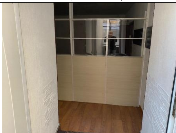
Фото № 9 – Внутреннее состояние помещения
