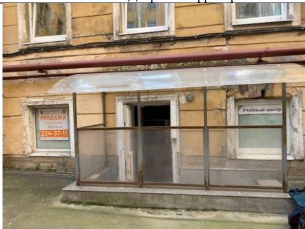
Фото № 7 – Окна помещения
