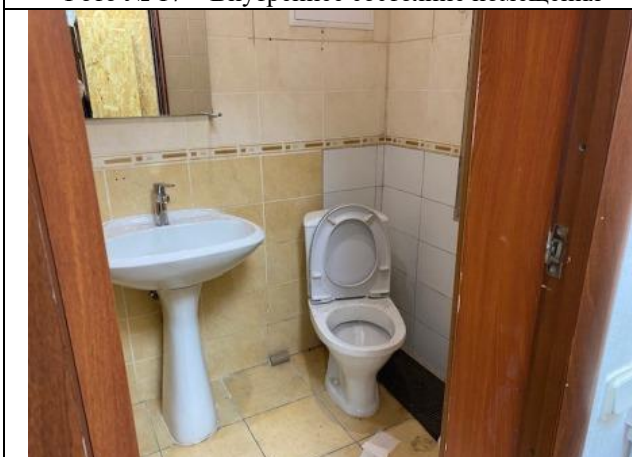
Фото № 19 – Внутреннее состояние помещения
