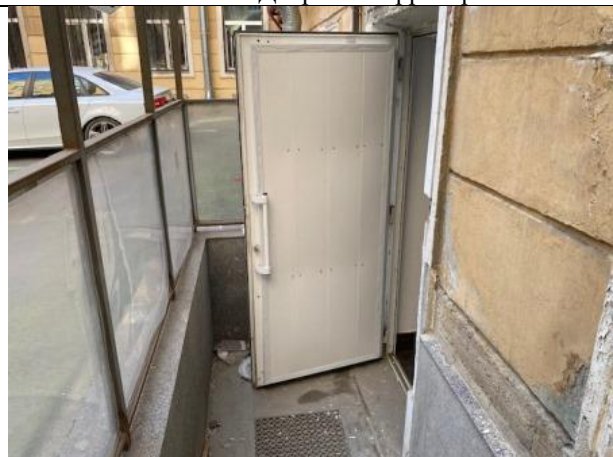
Фото № 8 – Отдельный со двора через приямок
