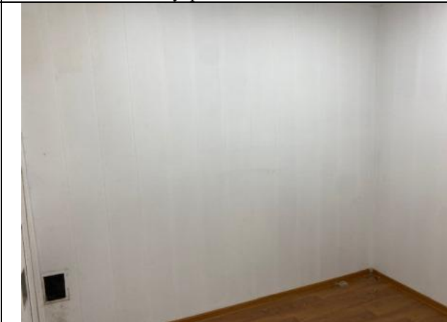
Фото № 24 – Внутреннее состояние помещения
