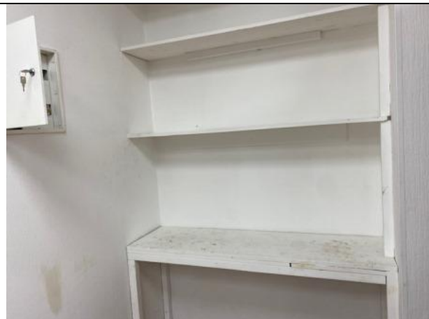
Фото № 14 – Внутреннее состояние помещения
