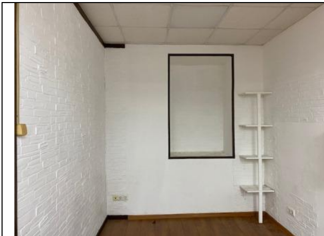
Фото № 21 – Внутреннее состояние помещения
