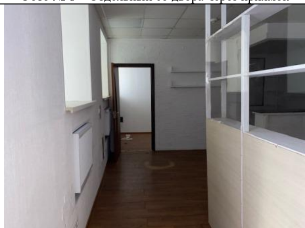
Фото № 10 – Внутреннее состояние помещения
