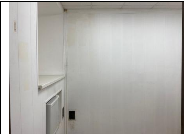
Фото № 22 – Внутреннее состояние помещения
