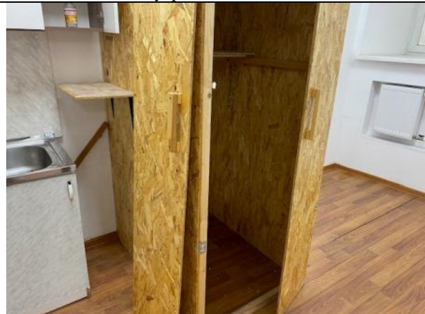
Фото № 16 – Внутреннее состояние помещения
