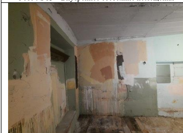
Фото № 15 – Внутреннее состояние помещения
