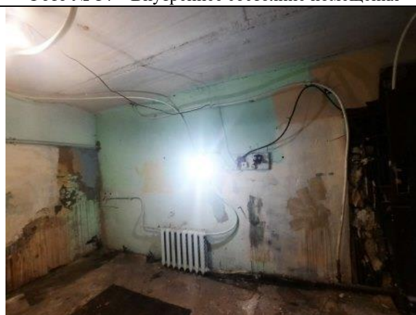
Фото № 16 – Внутреннее состояние помещения
