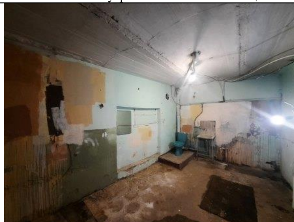
Фото № 14 – Внутреннее состояние помещения
