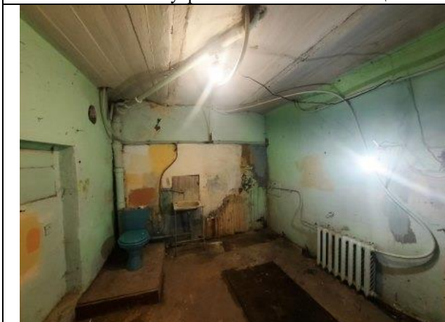
Фото № 13 – Внутреннее состояние помещения
