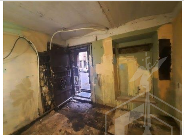
Фото № 10 – Внутреннее состояние помещения
