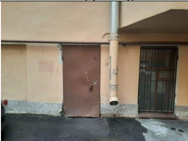
Фото № 9 – Вход в помещение со двора
