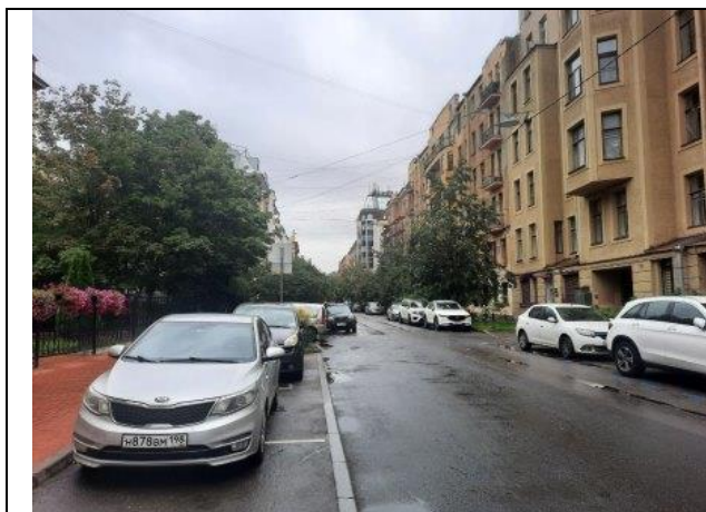
Фото № 1 – Подъездные пути
