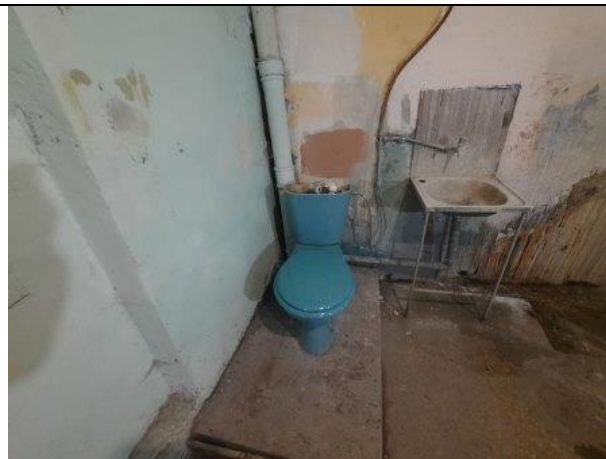
Фото № 12 – Внутреннее состояние помещения
