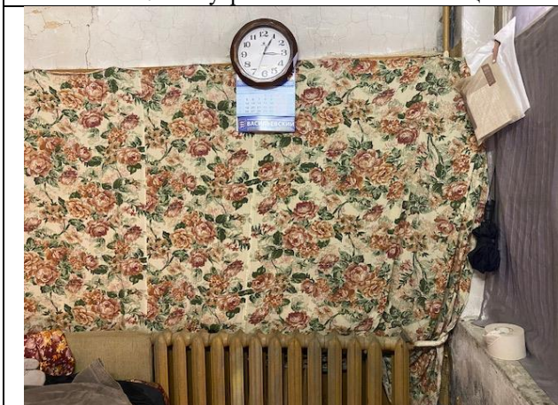
Фото № 9 – Внутреннее состояние помещения
