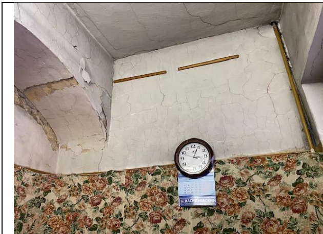
Фото № 7 – Внутреннее состояние помещения
