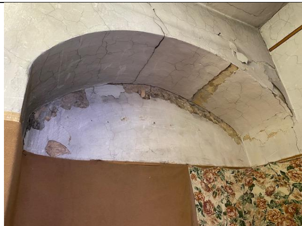
Фото № 8 – Внутреннее состояние помещения
