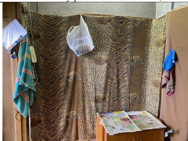
Фото № 10 – Внутреннее состояние помещения
