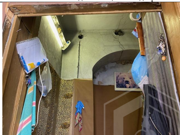
Фото № 6 – Внутреннее состояние помещения
