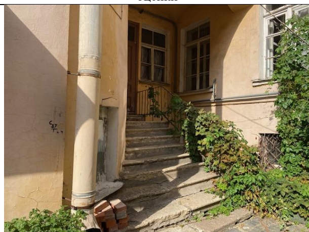
Фото № 4 – Вход в помещение со двора
