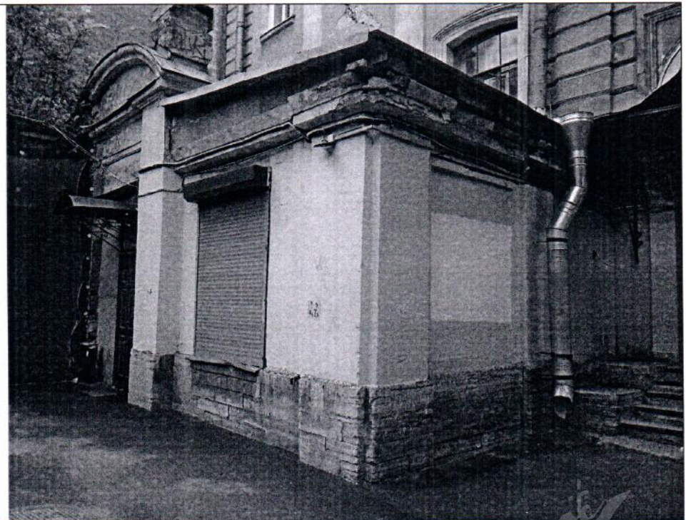
Описание: Вид Объекта снаружи
