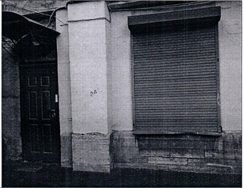
Описание: Вид Объекта снаружи
