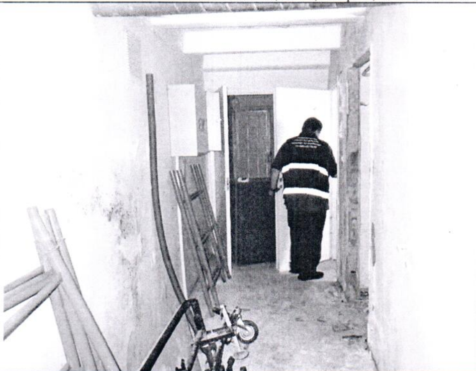
Описание: Вид внутри Объекта (Объект захламлен мусором)
