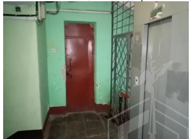
Фото 10. Вход в помещение
