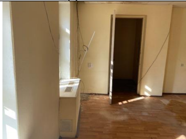
Фото № 18 – Внутреннее состояние помещения
