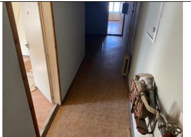
Фото № 8 – Внутреннее состояние помещения
