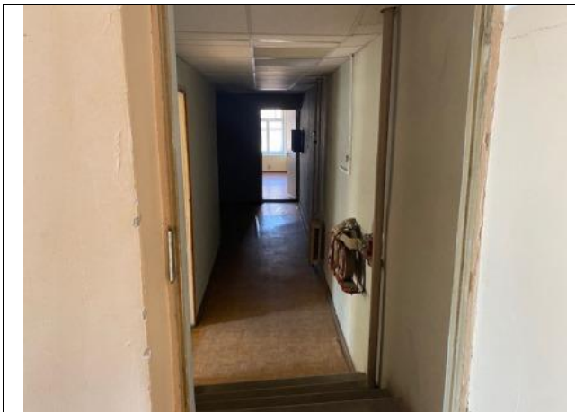
Фото № 7 – Внутреннее состояние помещения
