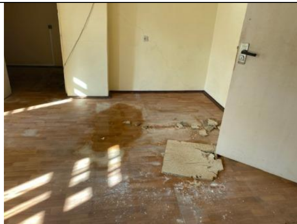
Фото № 16 – Внутреннее состояние помещения
