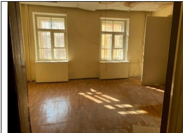
Фото № 15 – Внутреннее состояние помещения
