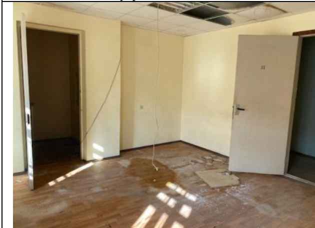
Фото № 17 – Внутреннее состояние помещения
