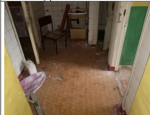
Фото 13. Внутреннее состояние Объекта оценки
