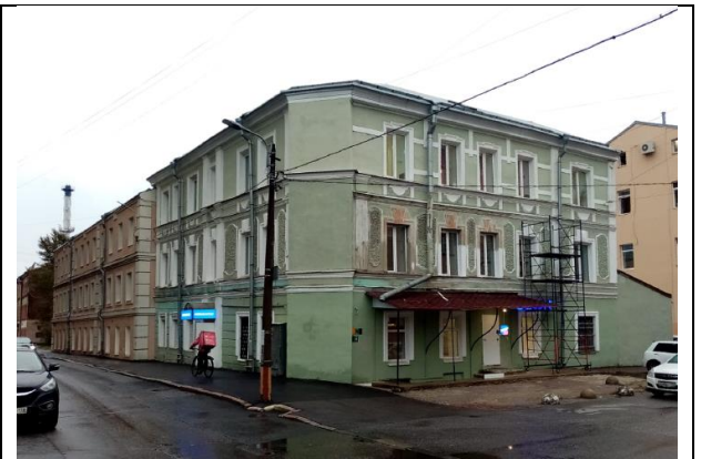
Фото 2. Вид здания, в котором расположен Объект оценки. Ближайшее окружение
