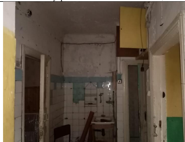
Фото 14. Внутреннее состояние Объекта оценки
