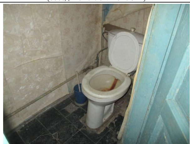
Фото 12. Внутреннее состояние Объекта оценки
