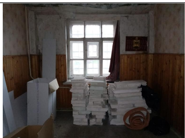
Фото 16. Внутреннее состояние Объекта оценки
