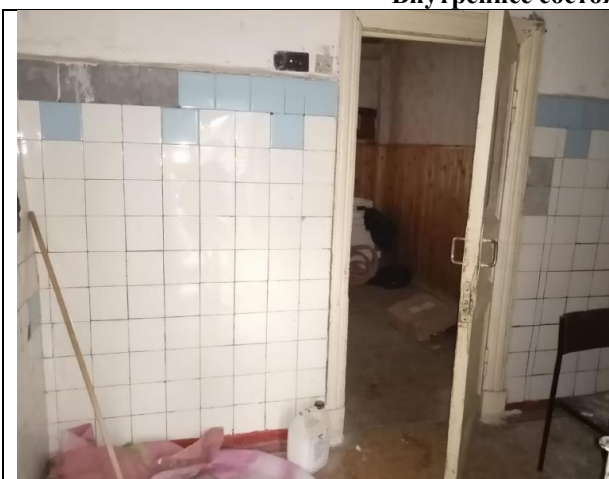
Фото 7. Внутреннее состояние Объекта оценки
