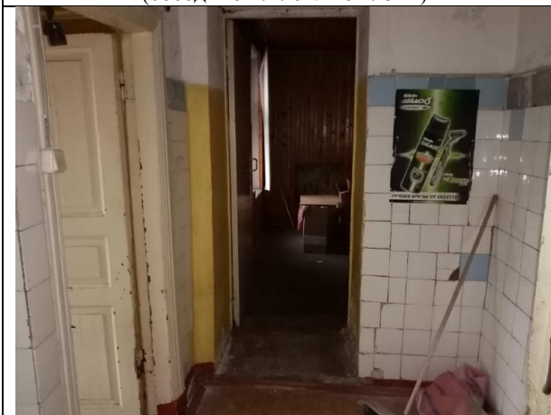
Фото 11. Внутреннее состояние Объекта оценки
