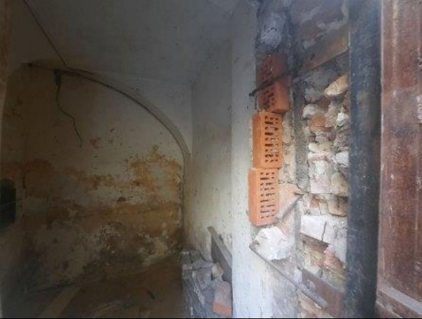
Фото № 11 – Внутреннее состояние помещения
