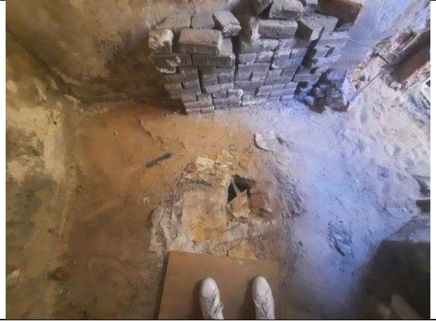
Фото № 14 – Внутреннее состояние помещения
