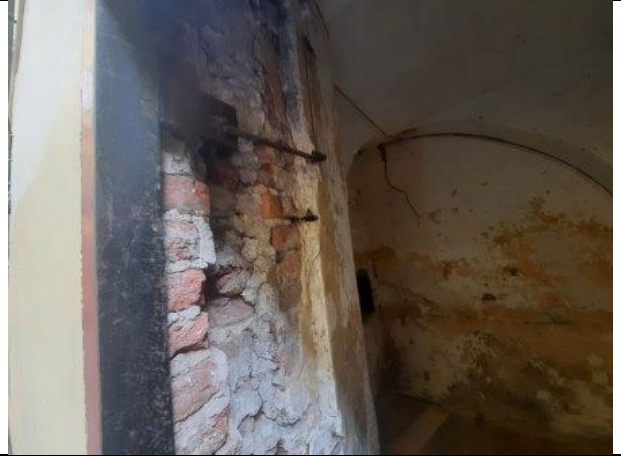
Фото № 12 – Внутреннее состояние помещения
