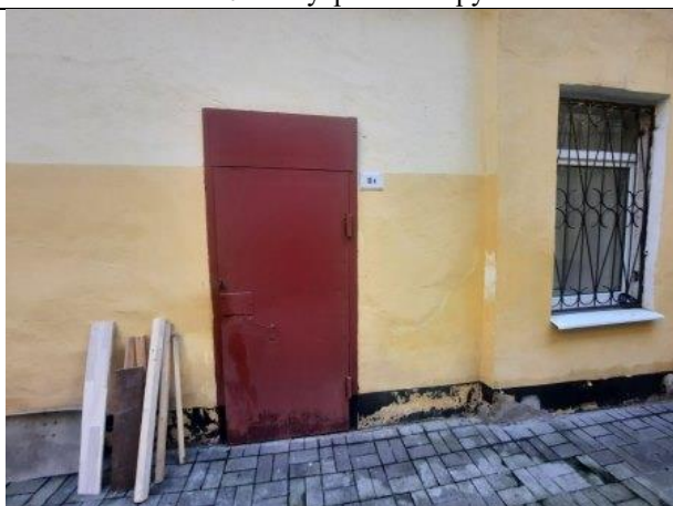
Фото № 9 – Вход в помещение со двора
