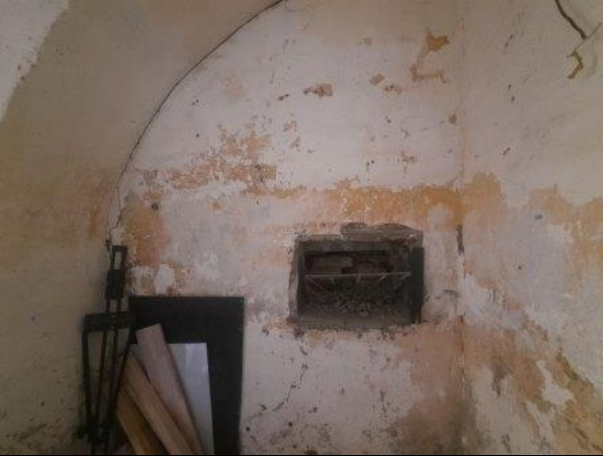
Фото № 13 – Внутреннее состояние помещения
