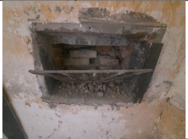
Фото № 16 – Внутреннее состояние помещения
