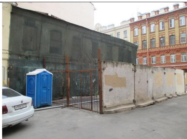
Фото № 6 – Состояние здания, в котором находится Объект оценки
