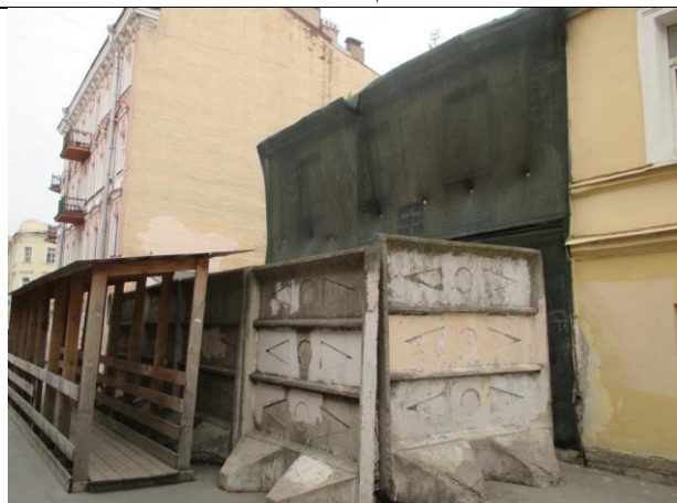
Фото № 10 – Состояние здания, в котором находится Объект оценки
