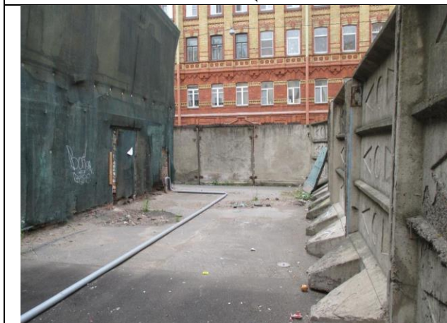
Фото № 7 – Состояние здания, в котором находится Объект оценки
