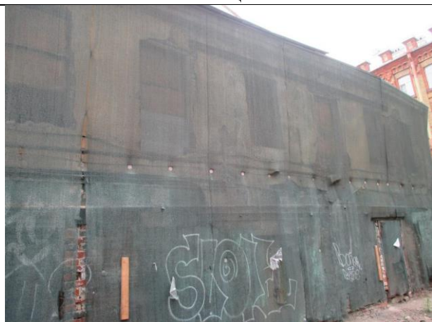
Фото № 8 – Состояние здания, в котором находится Объект оценки
