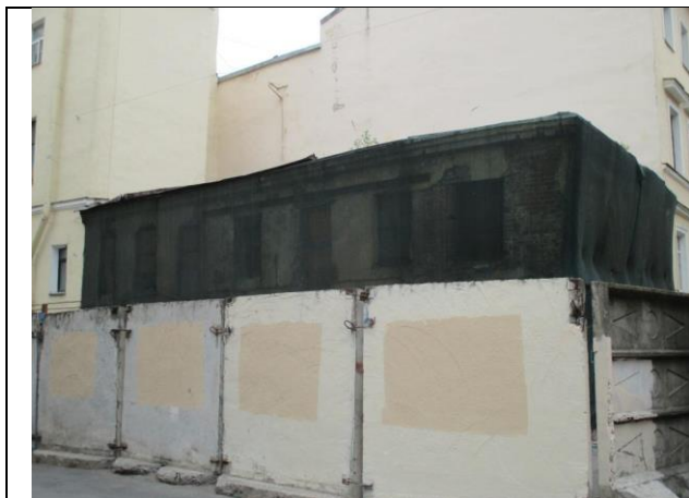
Фото № 5 – Состояние здания, в котором находится Объект оценки
