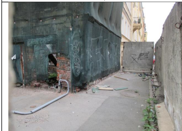
Фото № 9 – Состояние здания, в котором находится Объект оценки
