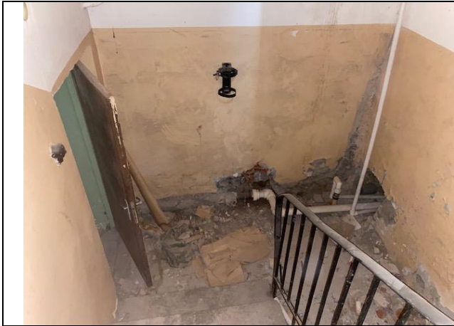
Фото № 7 – Внутреннее состояние помещения
