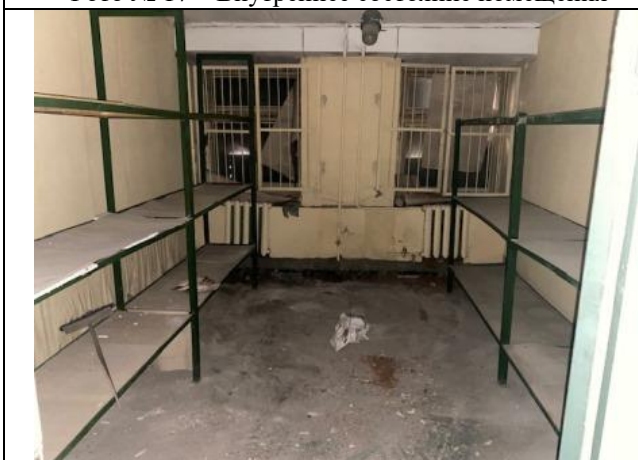
Фото № 19 – Внутреннее состояние помещения
