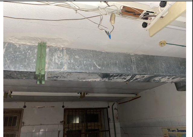
Фото № 10 – Внутреннее состояние помещения
