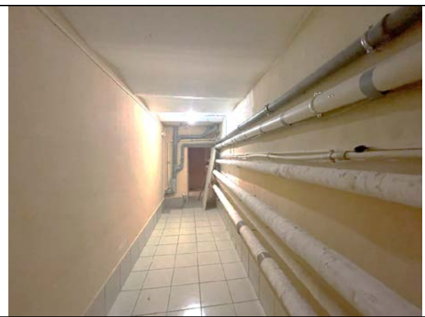
Фото 28. Типичное состояние Объекта оценки
