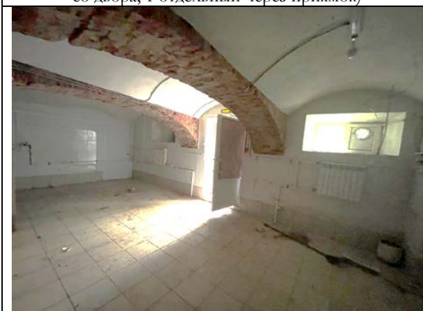
Фото 39. Типичное состояние Объекта оценки
