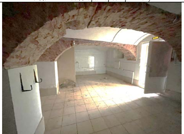
Фото 40. Типичное состояние Объекта оценки
