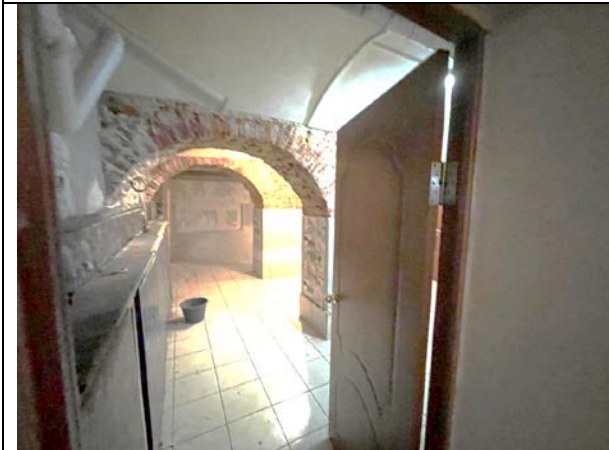
Фото 45. Типичное состояние Объекта оценки
