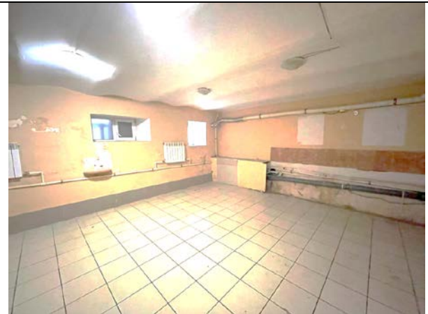
Фото 30. Типичное состояние Объекта оценки
