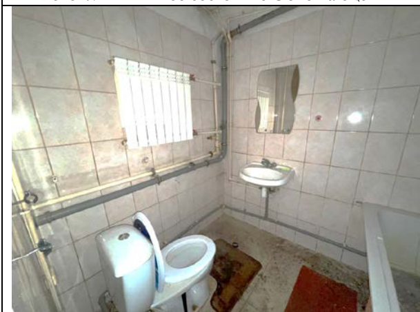
Фото 49. Типичное состояние Объекта оценки
