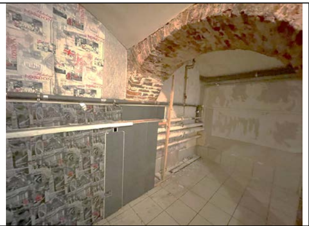
Фото 44. Типичное состояние Объекта оценки
