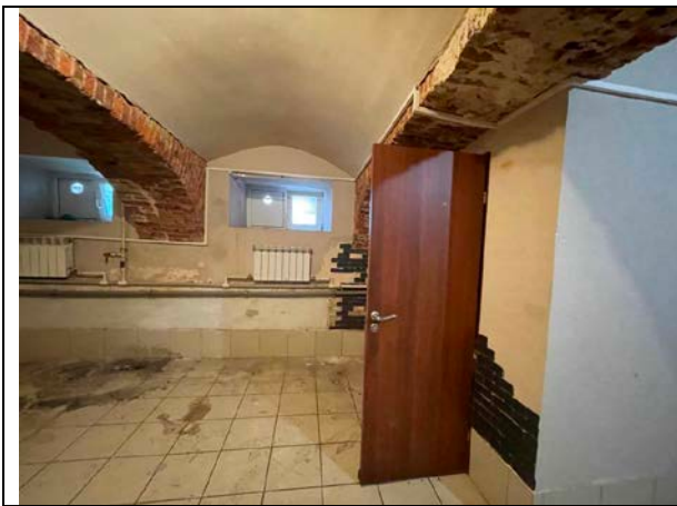
Фото 43. Типичное состояние Объекта оценки
