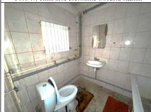
Фото 49. Типичное состояние Объекта оценки
