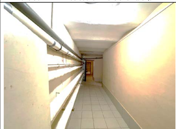
Фото 32. Типичное состояние Объекта оценки
