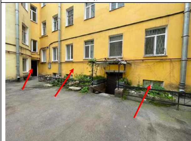
Фото 21. Вид здания расположения Объекта оценки, входная и оконная группа Объекта оценки (1 общий со двора)
