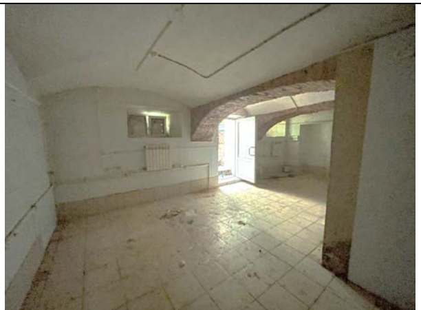
Фото 38. Входная группа Объекта оценки (1 отдельный со двора через приямок)
