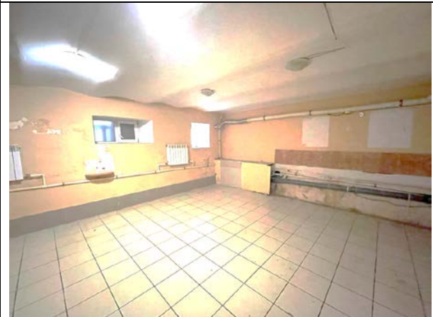
Фото 30. Типичное состояние Объекта оценки
