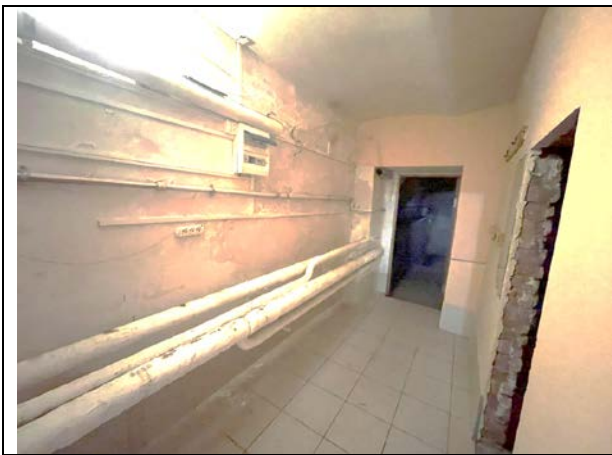
Фото 27. Типичное состояние Объекта оценки
