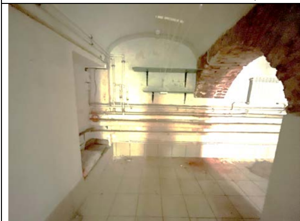
Фото 41. Типичное состояние Объекта оценки
