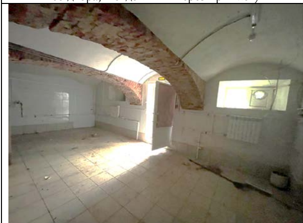
Фото 39. Типичное состояние Объекта оценки
