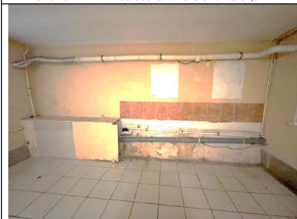
Фото 31. Типичное состояние Объекта оценки
