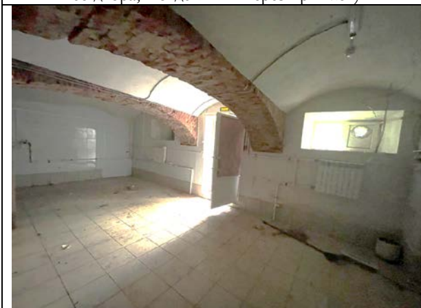
Фото 39. Типичное состояние Объекта оценки
