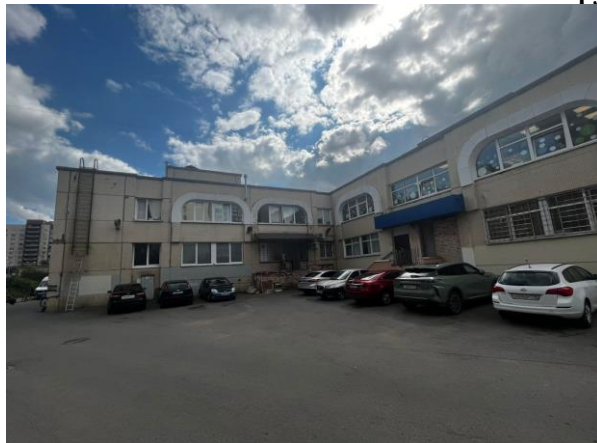
Фото 1. Вид здания Объекта оценки
