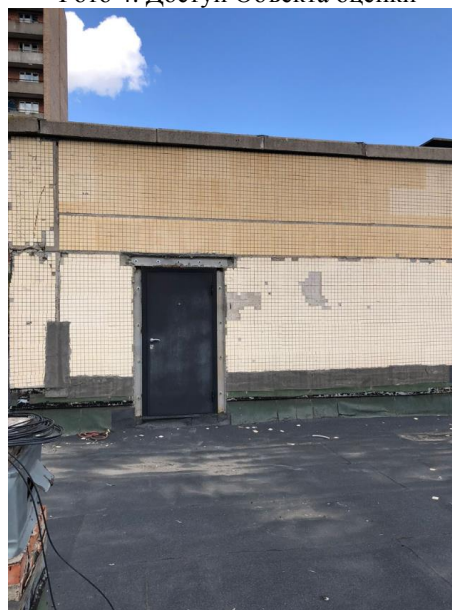
Фото 6. Отдельный вход с кровли - со двора
