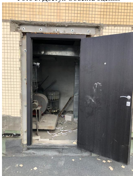
Фото 5. Отдельный вход с кровли - со двора
