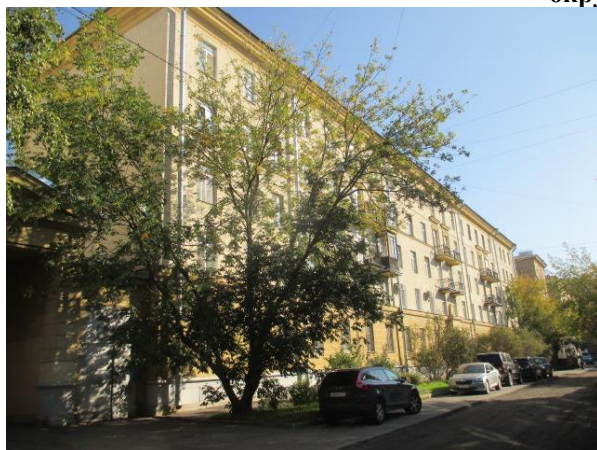
Фото 1. Вид здания, в котором расположен Объект оценки. Ближайшее окружение
