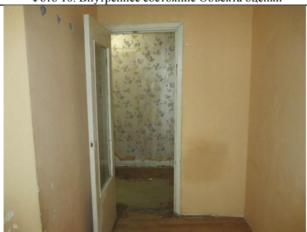
Фото 12. Внутреннее состояние Объекта оценки
