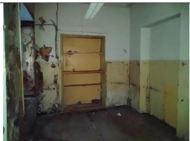
Фото 20. Внутреннее состояние Объекта оценки
