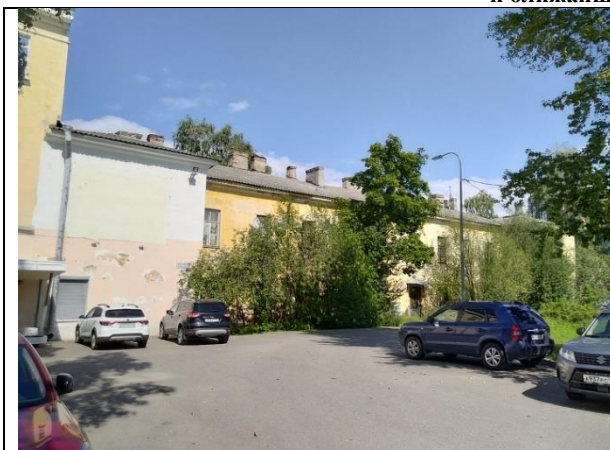
Фото 1. Вид здания, в котором расположен Объект оценки
