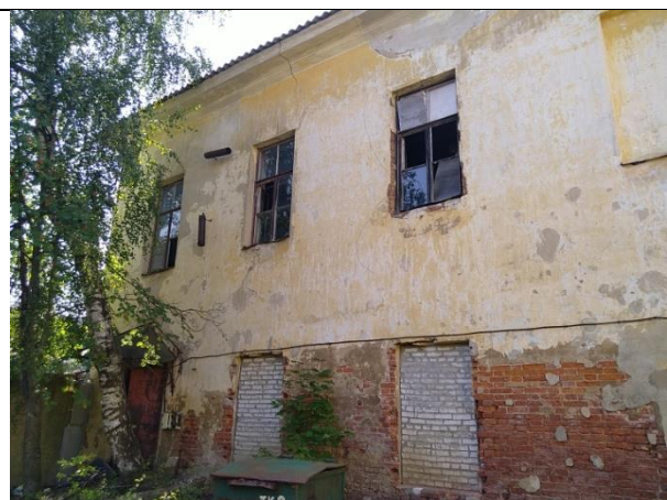
Фото 8. Вид здания, в котором расположен Объект оценки
