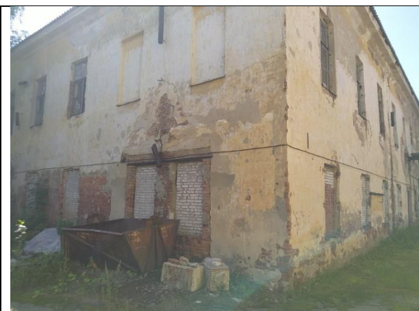
Фото 7. Вид здания, в котором расположен Объект оценки
