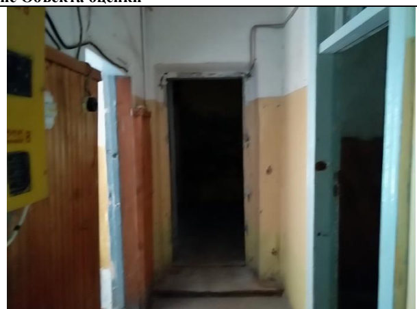
Фото 16. Внутреннее состояние Объекта оценки
