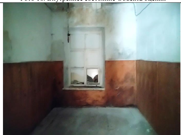
Фото 18. Внутреннее состояние Объекта оценки
