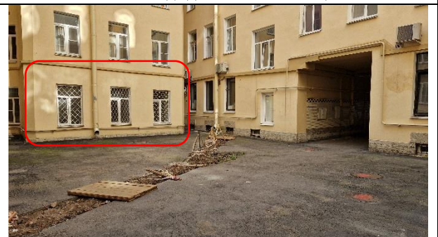
Фото 14. Внутридворовая территория, расположение Объекта оценки
