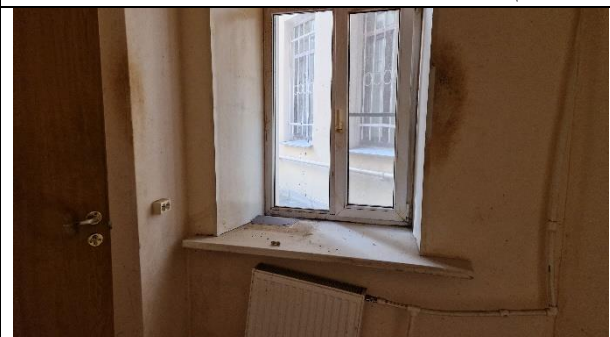
Фото 30. Типичное состояние Объекта оценки
