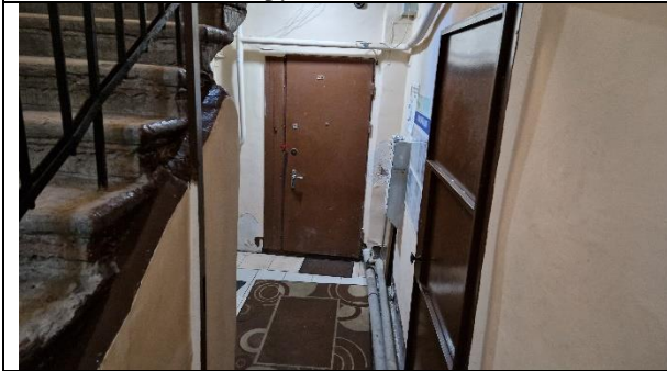
Фото 19. Состояние парадной Объекта оценки
