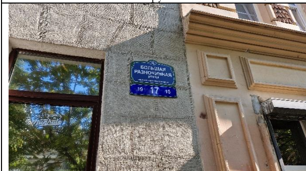
Фото 11. Адрес Объекта оценки
