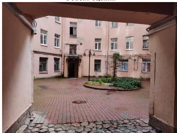
Фото 3. Дворовая территория. Ближайшее окружение
