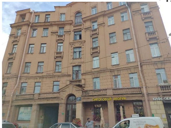
Фото 1. Вид здания, в котором расположен Объект оценки
