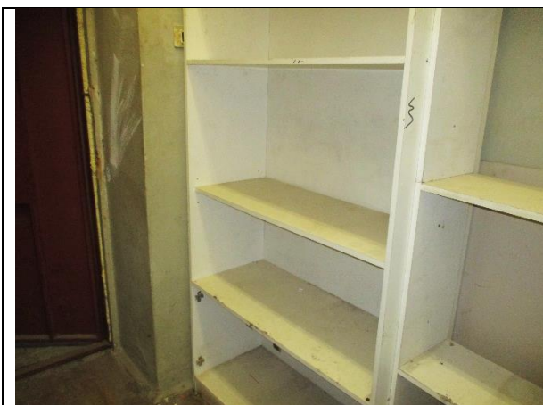
Фото 9. Внутреннее состояние Объекта оценки
