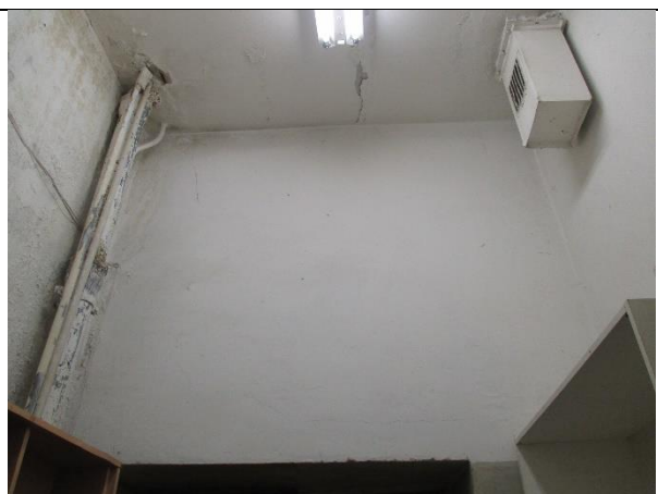
Фото 10. Внутреннее состояние Объекта оценки
