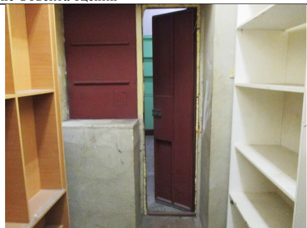
Фото 8. Внутреннее состояние Объекта оценки
