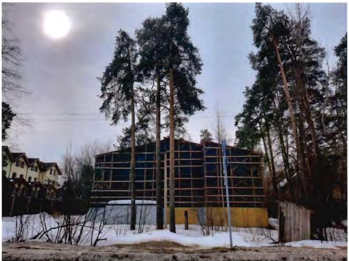
1. Общий вид на северный фасад объекта культурного наследия
