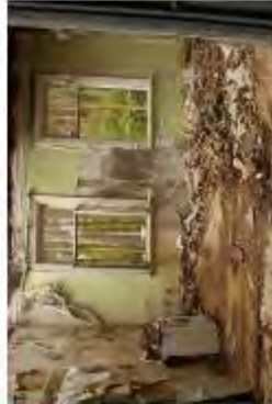
Фото 32. Вид из инспектора до начала профилактических работ на Объекте в 2019 г.
