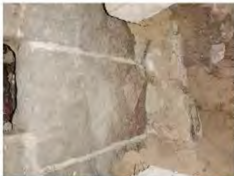
Фото 53. Цоколь жилого фасада
