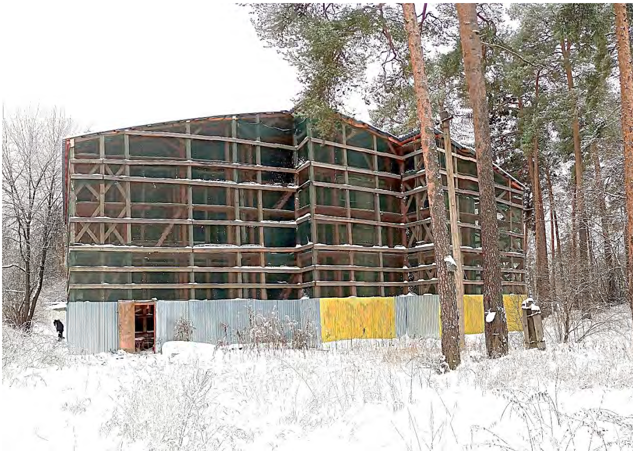
Фото 42. Вид со стороны ул. Максима Горького на северный фасад ОКН
