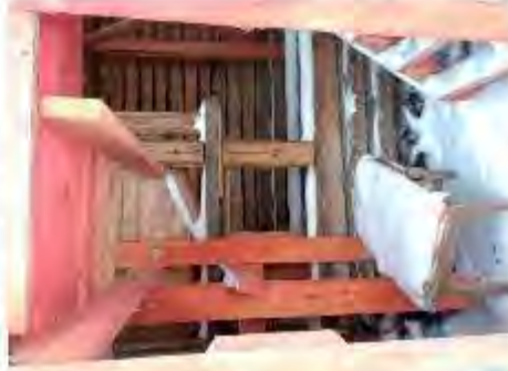
Фото 44. Более подробный вид на крышу (вид со стороны северного фасада) ОКН
