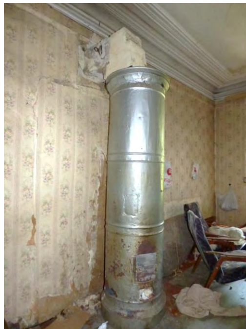
Фото 16. Виды интерьеров до начала противоаварийных работ на Объекте в 2019 г.
