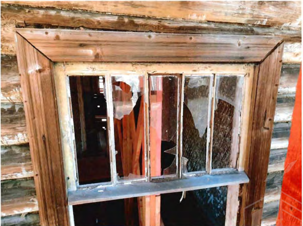
3. Историческая расстекловка оконных проемов
