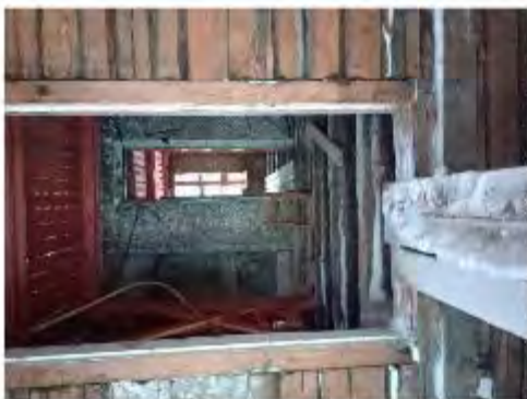
Фото 62. Вид на окно из помещений второго этажа
