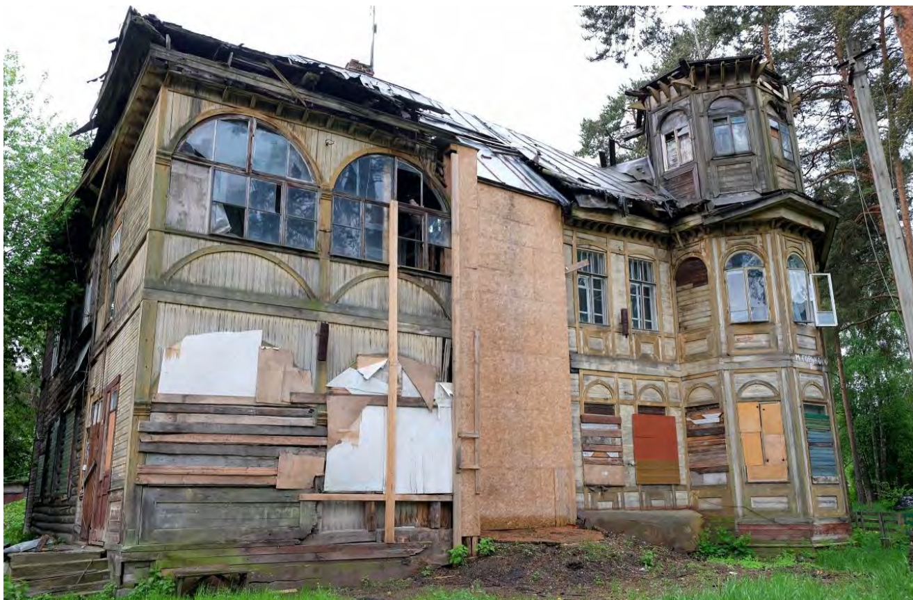
Фото 12. Объект после обрушения в 2018 г.
