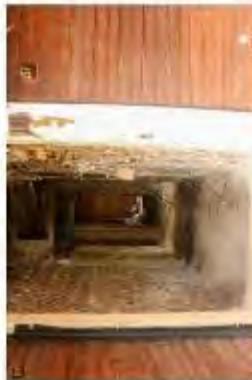
Фото 24. Вид из инспектора до начала профилактических работ на Объекте в 2019 г.
