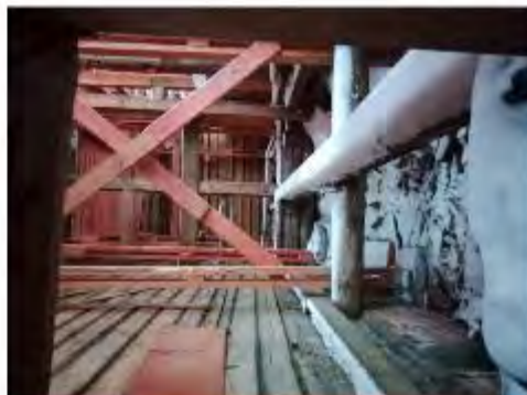
Фото 51. Восточный фасад, покат
