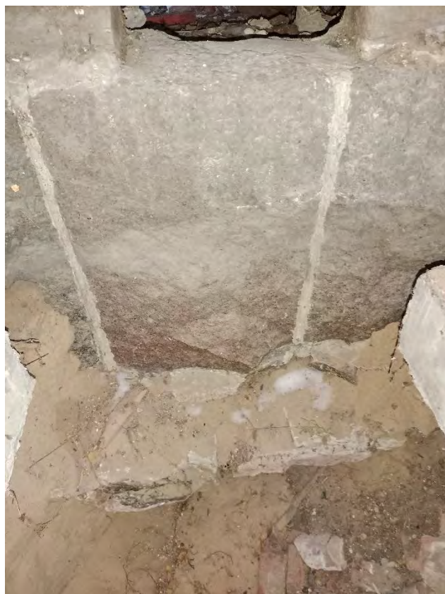
Фото 53. Цоколь южного фасада
