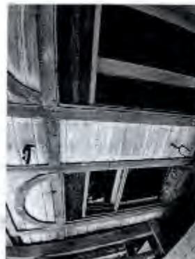
10. Фрагмент северо-западной башни. Состояние стен и отделки
