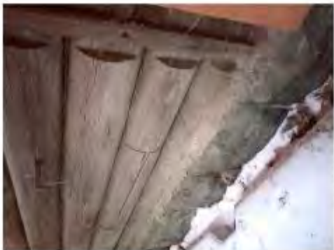
Фото 49. Восточный фасад, покат
