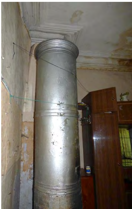
Фото 15. Виды интерьеров до начала противоаварийных работ на Объекте в 2019 г.
