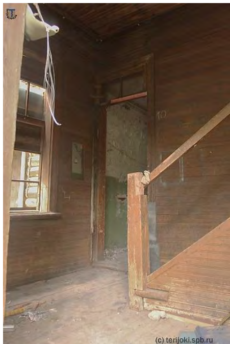
Фото 27. Виды интерьеров до начала противоаварийных работ на Объекте в 2019 г.
