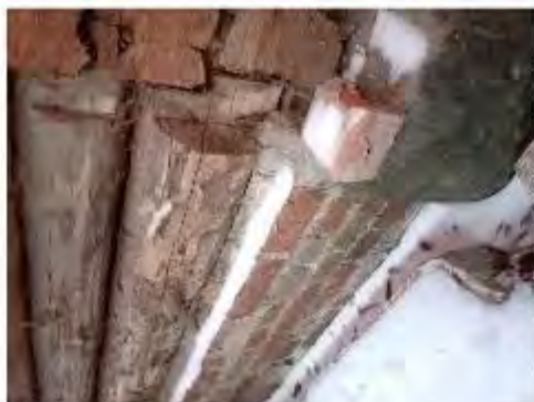
Фото 52. Угол жилого и производственного помещений
