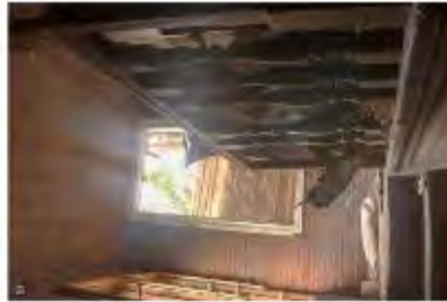
Фото 26. Вид из инспектора до начала профилактических работ на Объекте в 2019 г.
