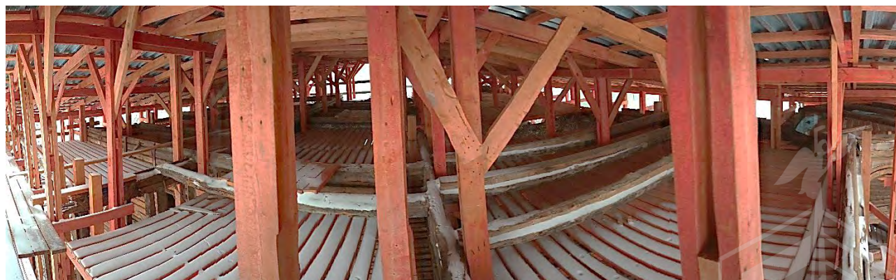
Фото 69. Панорамный вид подкровельное пространство каркаса
