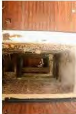
Фото 31. Вид из инспектора до начала профилактических работ на Объекте в 2019 г.
