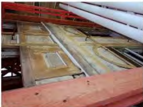
Фото 63. Фрагмент северного фасада со второго этажа
