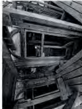
6. Фронтонт северо-западной башни
