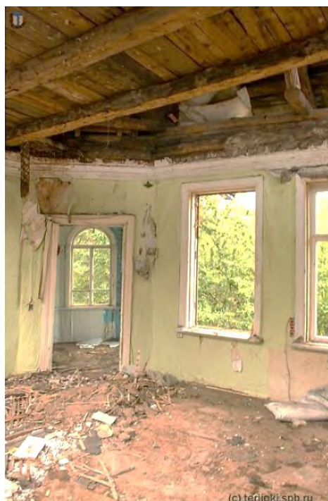
Фото 25. Виды интерьеров до начала противоаварийных работ на Объекте в 2019 г.
