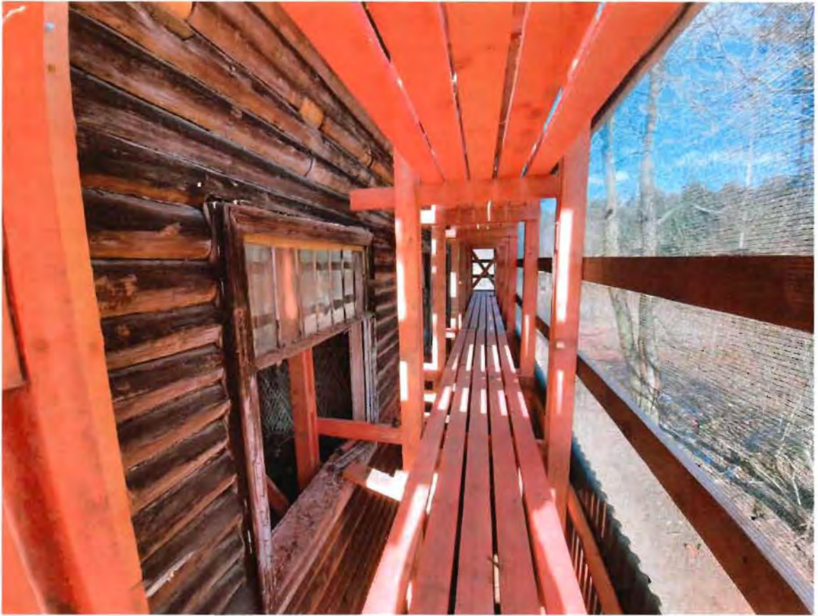
2. Вид на западный фасад со строительных лесов
