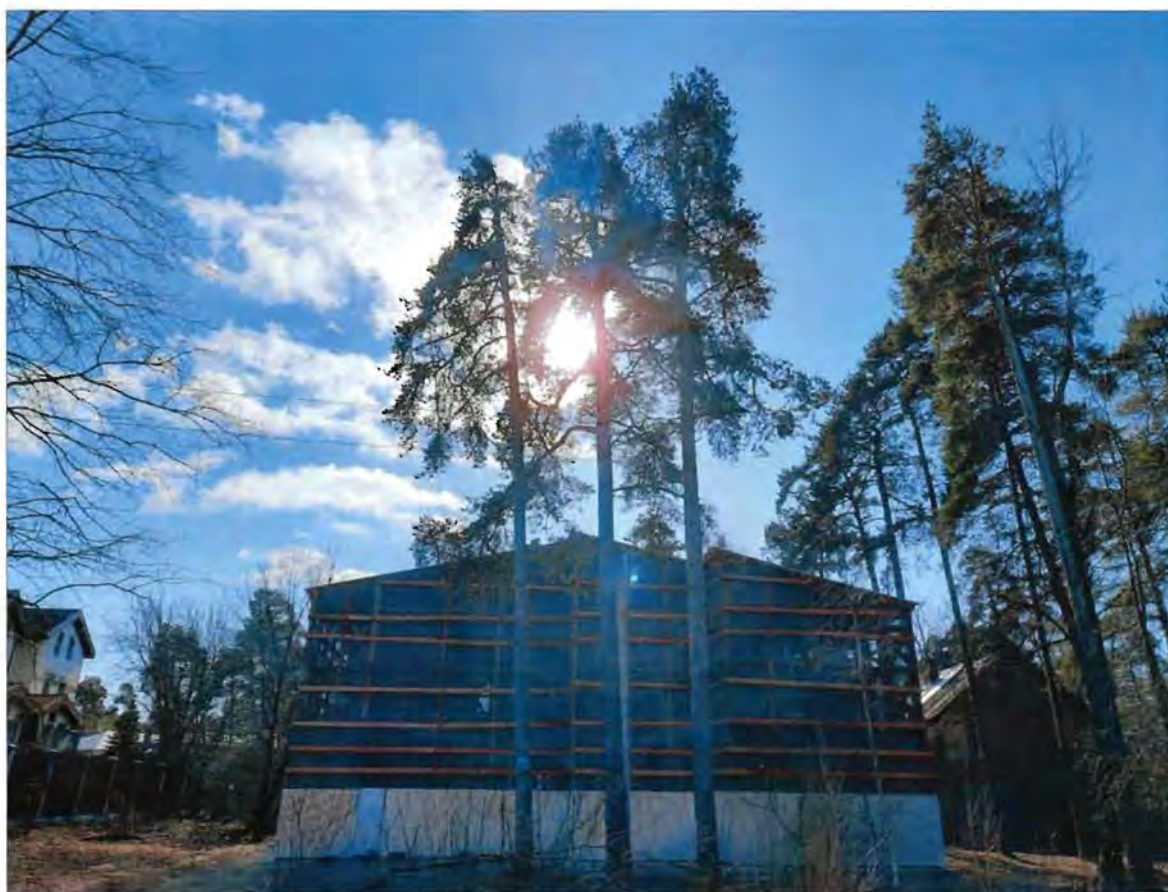
1. Общий вид со стороны северного фасада
