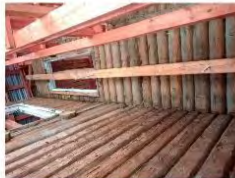
Фото 55. Угол жилого и производственного помещений
