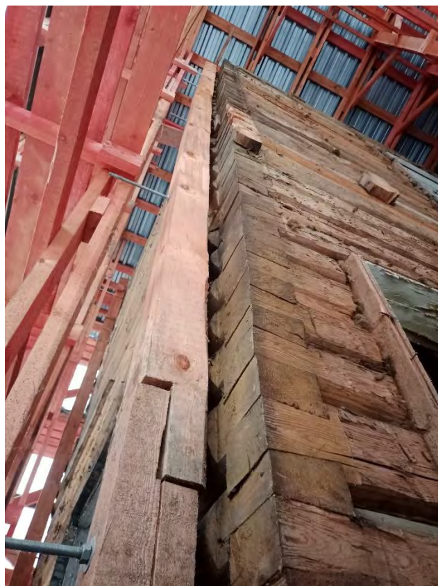
Фото 57. Угол юго-западного объема здания, вид на крышу каркаса
