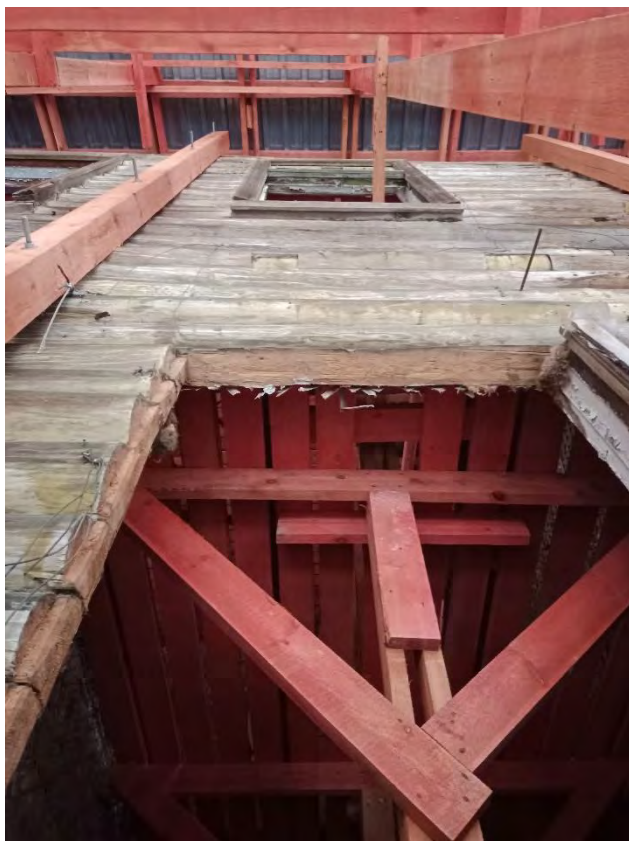
Фото 60. Фрагмент западного фасада
