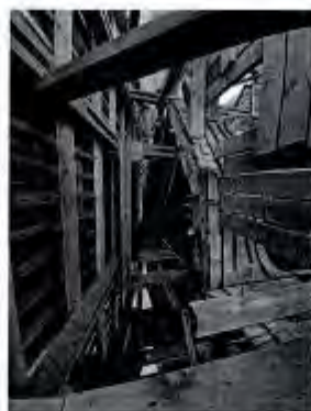
18. Временные защитные конструкции над объемом северо-западной башни
