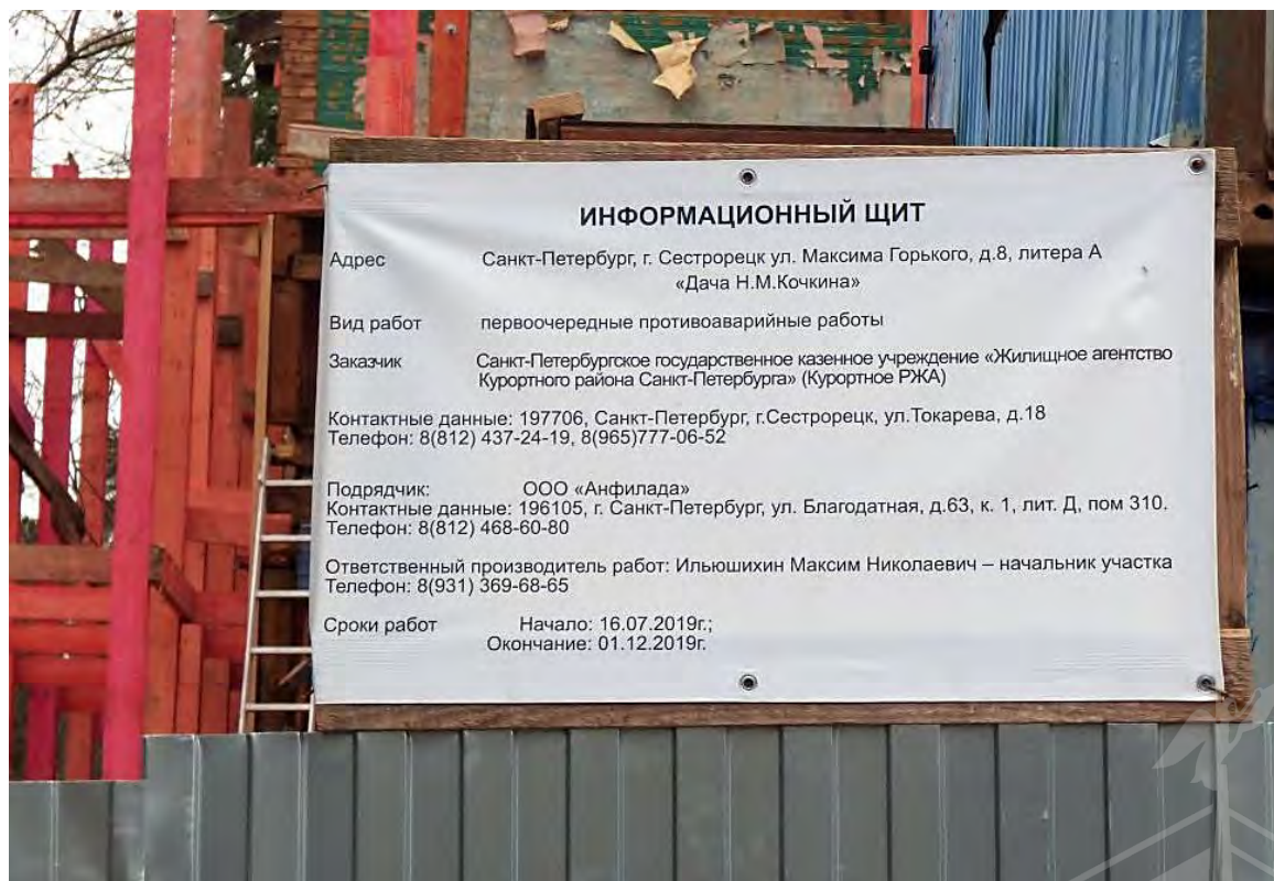
Фото 35. Первоочередные противоаварийные работы на Объекте в 2019 г.
