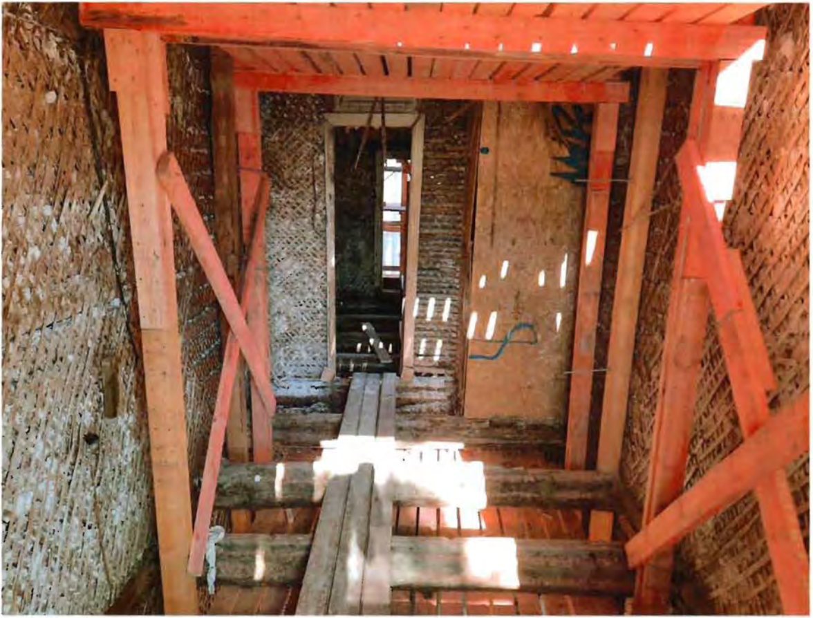
4. Вид на внутренние конструкции
