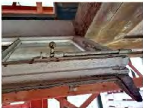
Фото 64. Обрамление оконных проемов обшитого законченными и оштукатуренными ч.п.п. (второго) этажа, 5 (второй этаж)
