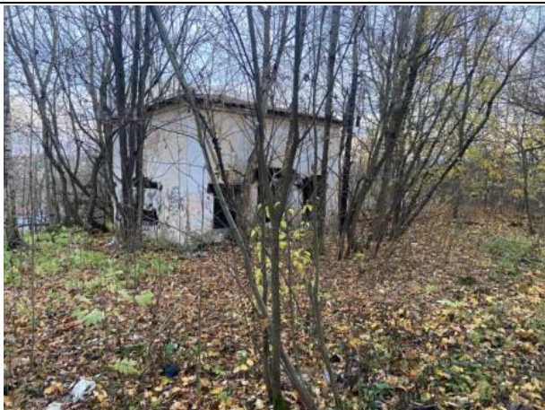
Фото № 9. Внешний вид здания литеры Д
