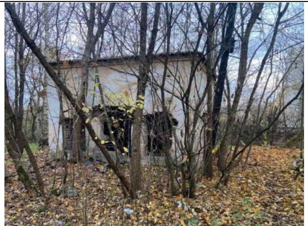
Фото № 8. Внешний вид здания литеры Д
