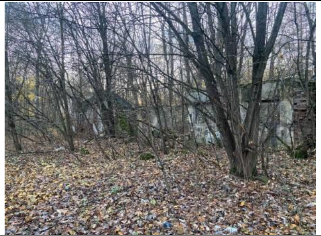
Фото № 12. Внешний вид здания литера К
