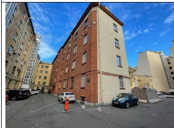
Фото 19. Вид здания расположения Объекта оценки
