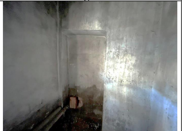
Фото 24. Типичное состояние Объекта оценки
