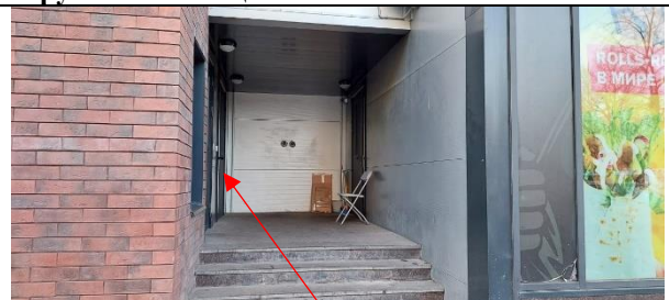
Фото 6. Общий вход со двора
