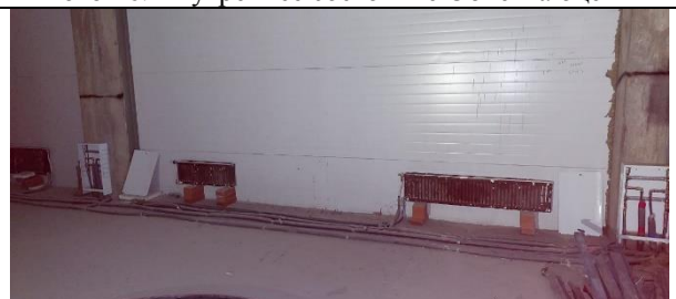
Фото 18. Внутреннее состояние Объекта оценки
