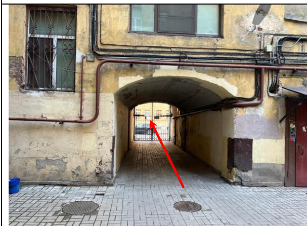
Фото 9. Проход через арку к Объекту оценки
