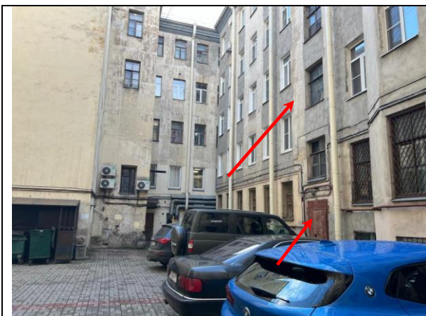
Фото 11. Вид здания Объекта оценки, входная группа Объекта оценки
