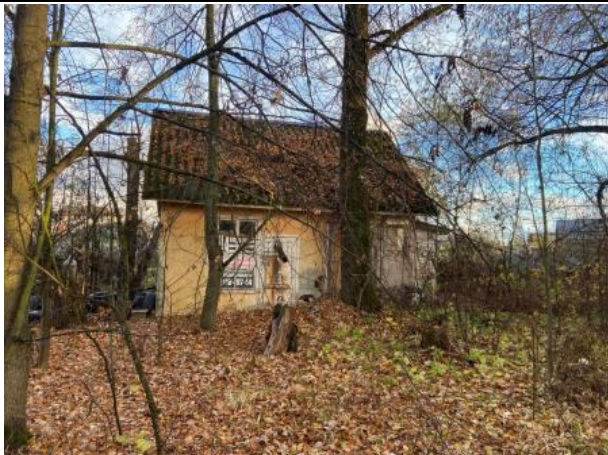
Фото № 15. Внешний вид здания литеры В
