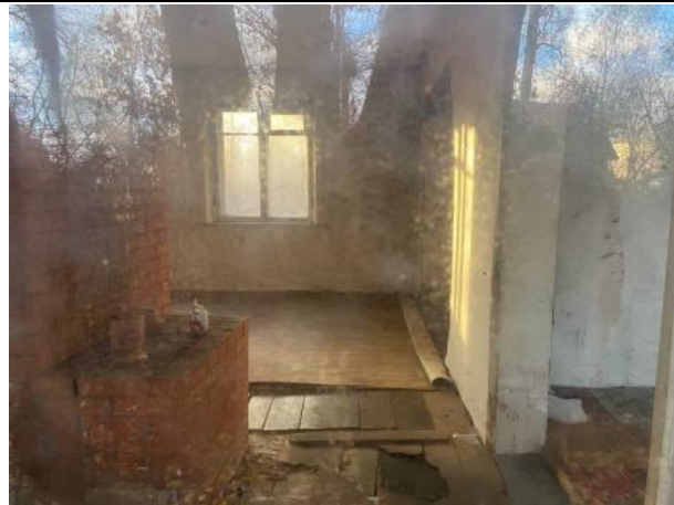
Фото № 12. Внутреннее состояние здание литеры Б
