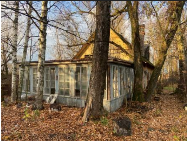
Фото № 9. Внешний вид здания литеры Б
