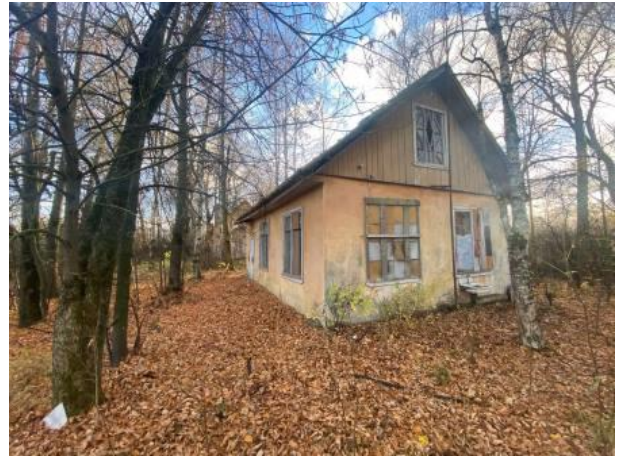
Фото № 20. Внутреннее состояние здание литера Е
