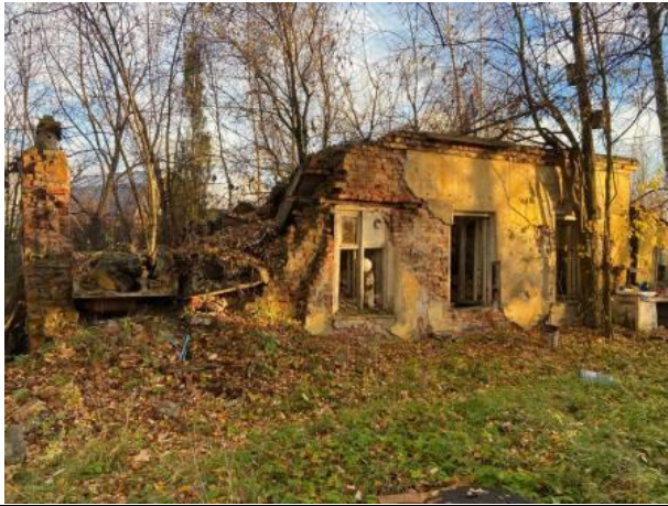
Фото № 17. Внешний вид здания литера Д
