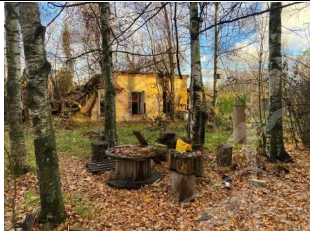
Фото № 16. Внешний вид здания литеры Д
