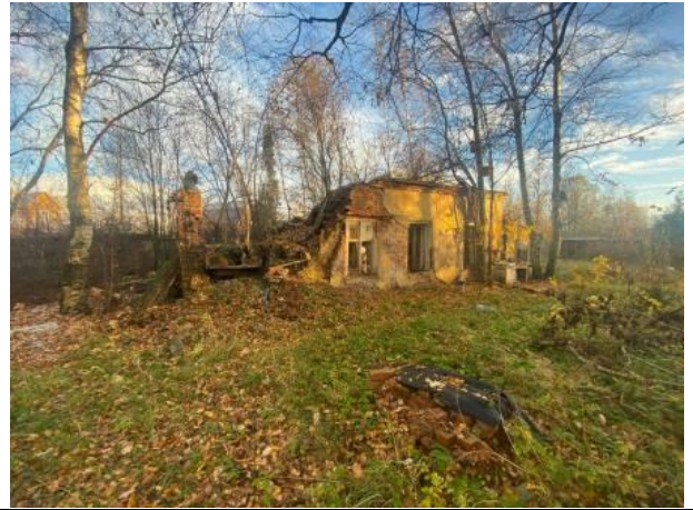
Фото № 18. Внешний вид здания литера Д
