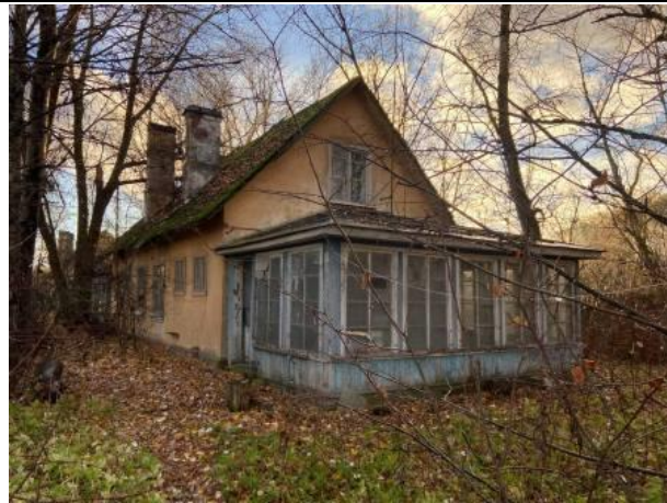
Фото № 10. Внешний вид здания литеры Б
