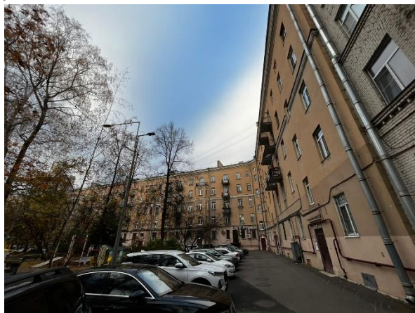
Фото 2. Вид здания, в котором расположен Объект оценки
