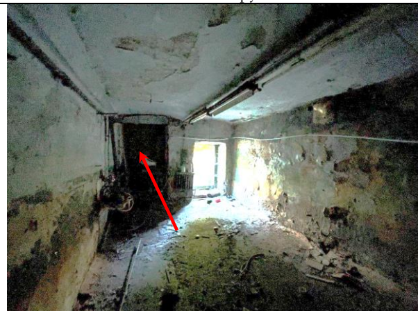
Фото 17. Типичное состояние Объекта оценки, оконная группа Объекта оценки
