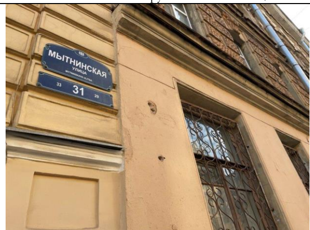
Фото 8. Адрес Объекта оценки
