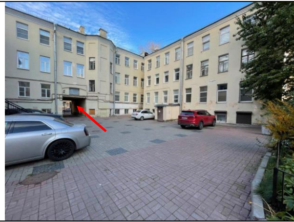
Фото 13. Внутривдворовая территория Объекта оценки
