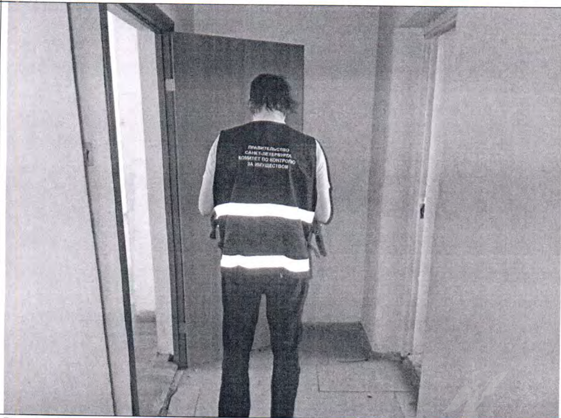
Описание: Вид внутри ч.п. 1 помещения 5-Н Объекта
