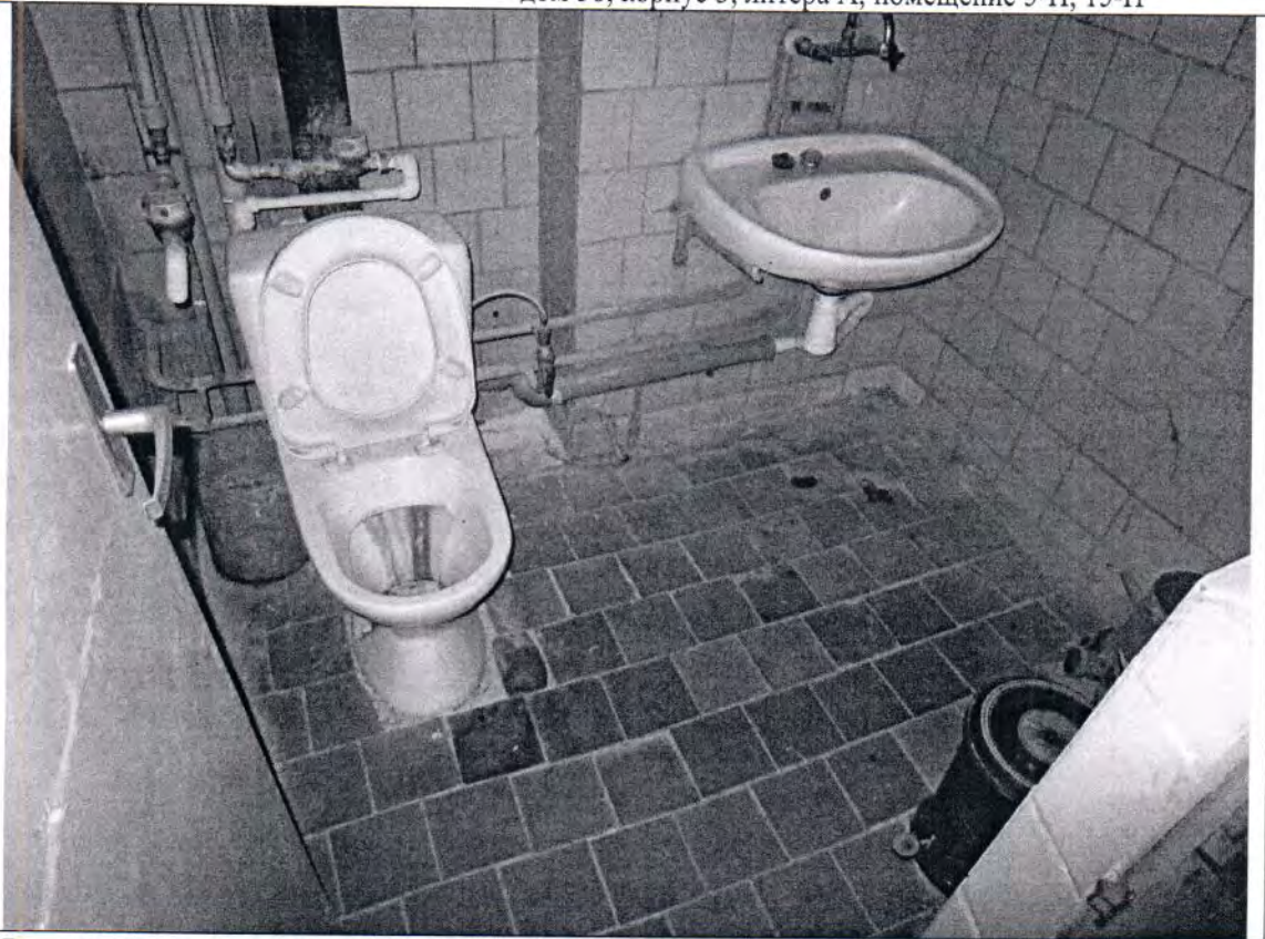
Описание: Вид внутри ч.п. 3 помещения 15-Н Объекта
