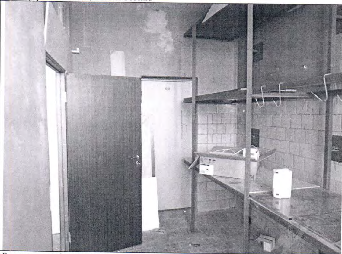
Описание: Вид внутри ч.п. 2 помещения 5-Н Объекта
