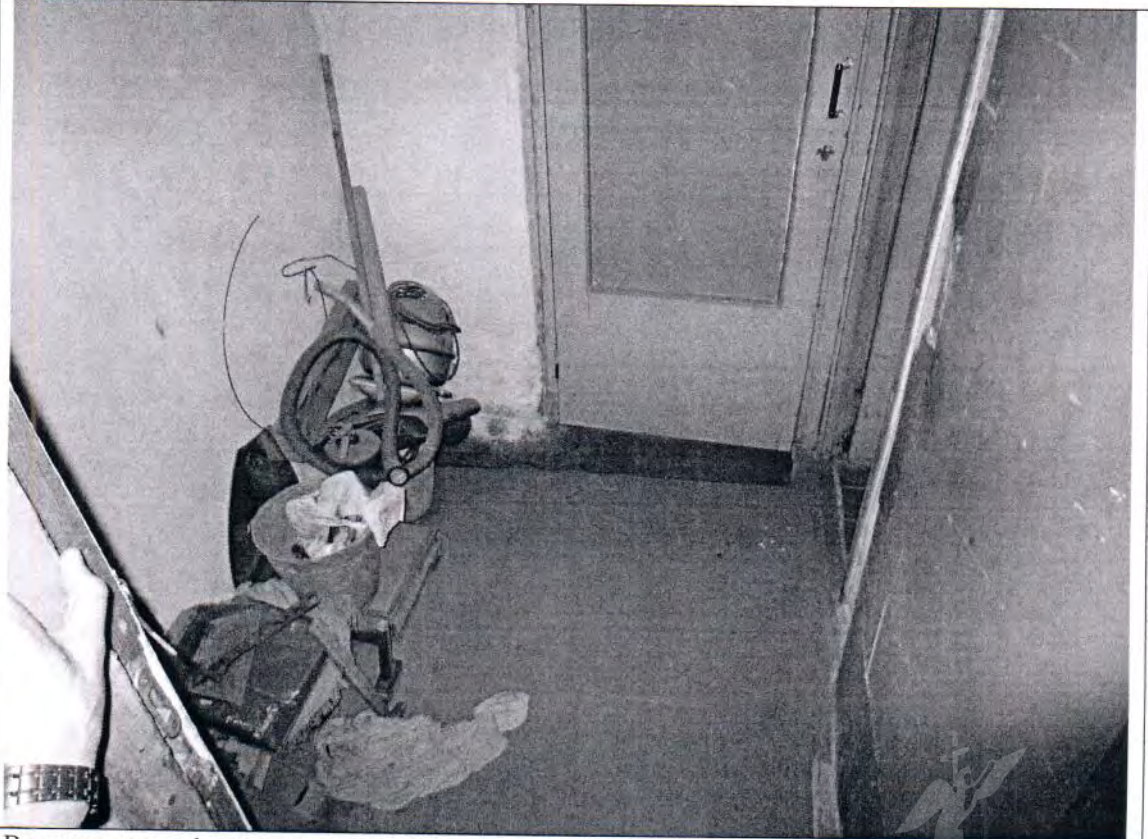
Описание: Вид внутри ч.п. 1 помещения 15-Н Объекта
