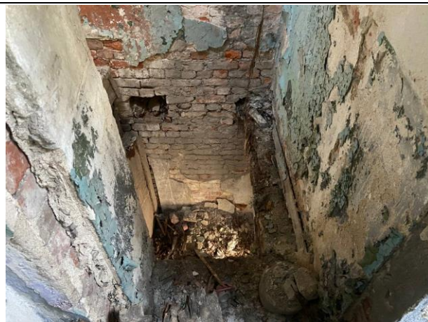
Фото № 22. Внутреннее состояние здания
