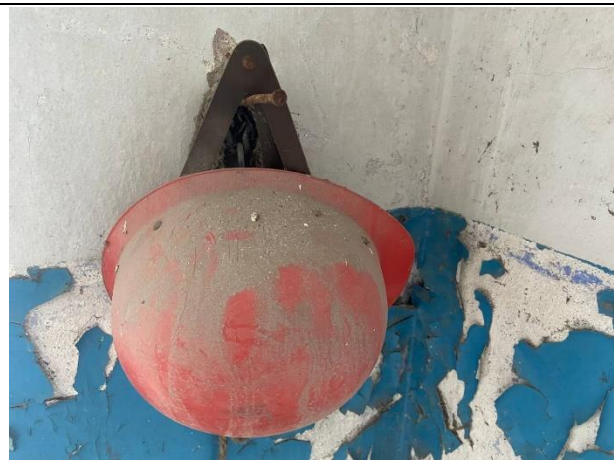
Фото № 26. Внутреннее состояние здания
