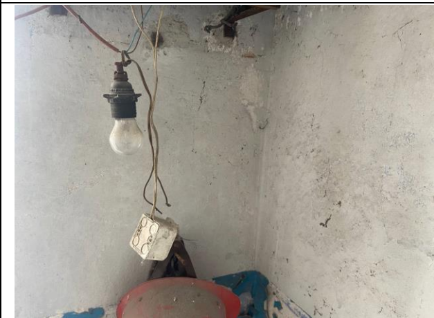
Фото № 25. Внутреннее состояние здания
