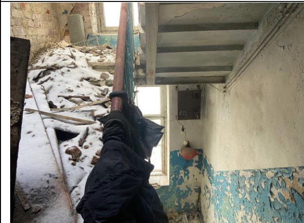
Фото № 23. Внутреннее состояние здания
