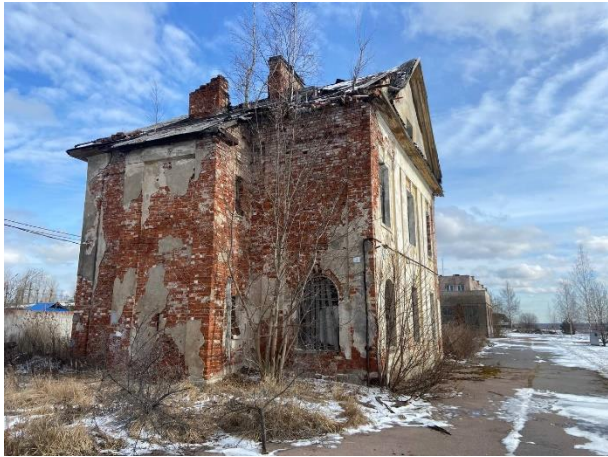
Фото № 7. Внешний вид здания и земельного участка
