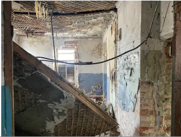
Фото № 13. Внутреннее состояние здания
