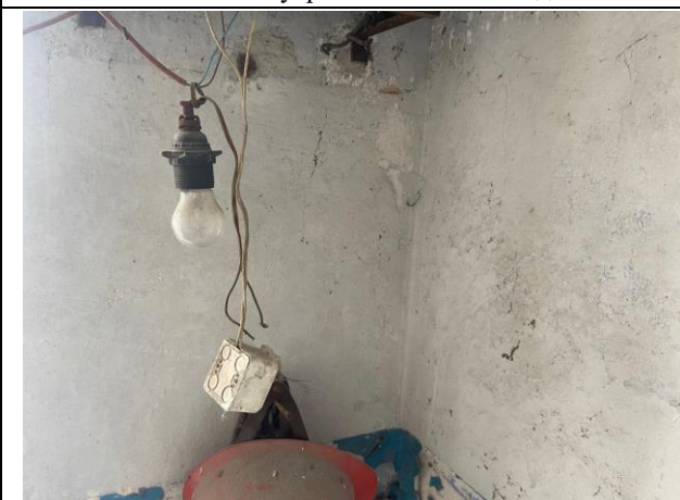
Фото № 25. Внутреннее состояние здания
