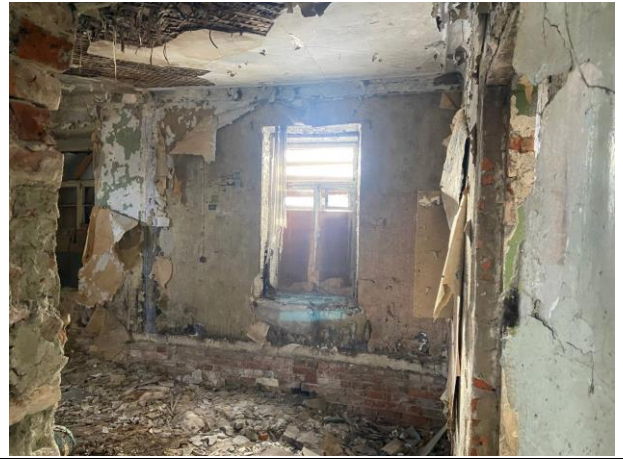
Фото № 14. Внутреннее состояние здания
