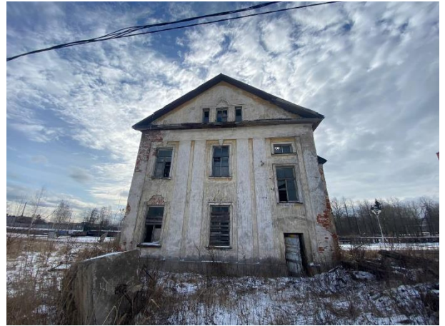
Фото № 8. Внешний вид здания и земельного участка
