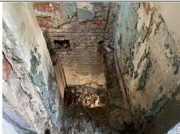
Фото № 22. Внутреннее состояние здания
