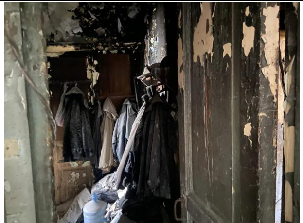
Фото № 18. Внутреннее состояние здания
