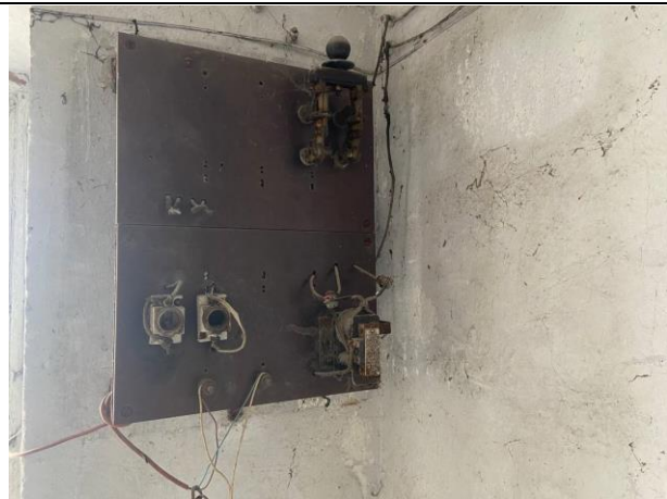
Фото № 24. Внутреннее состояние здания
