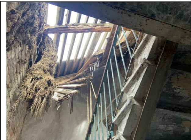
Фото № 21. Внутреннее состояние здания
