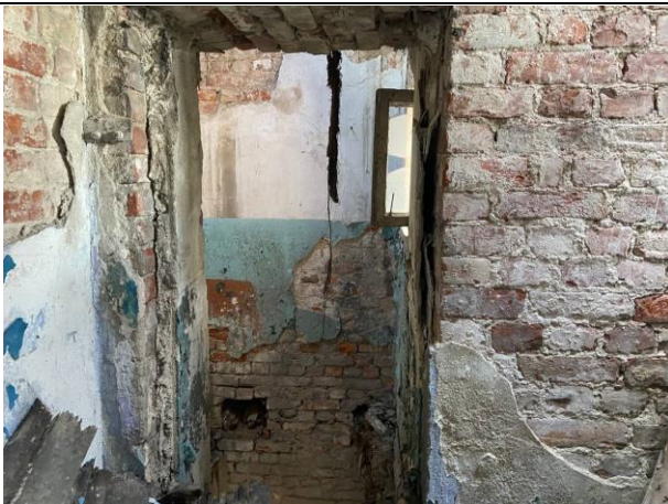
Фото № 19. Внутреннее состояние здания
