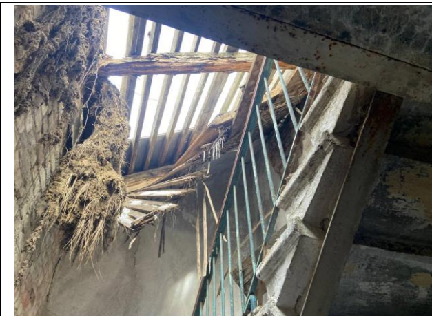
Фото № 21. Внутреннее состояние здания
