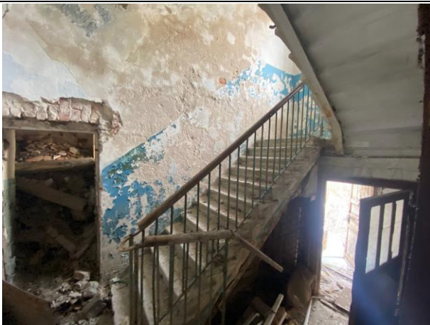
Фото № 17. Внутреннее состояние здания
