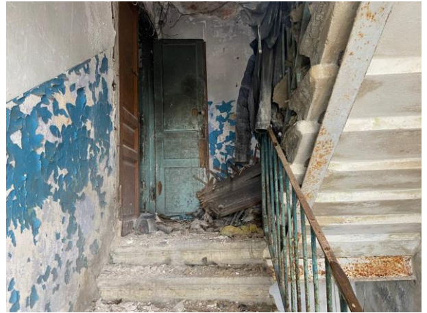
Фото № 16. Внутреннее состояние здания
