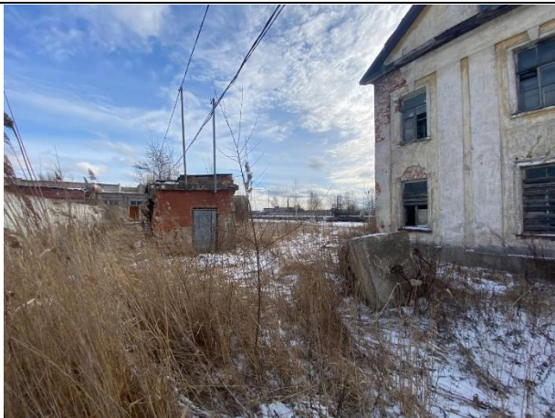
Фото № 9. Внешний вид здания и земельного участка
