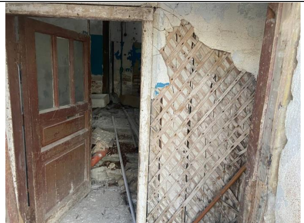
Фото № 10. Вход в здание
