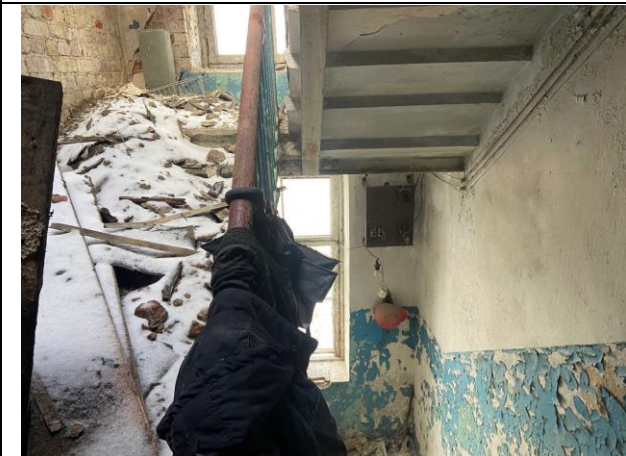
Фото № 23. Внутреннее состояние здания
