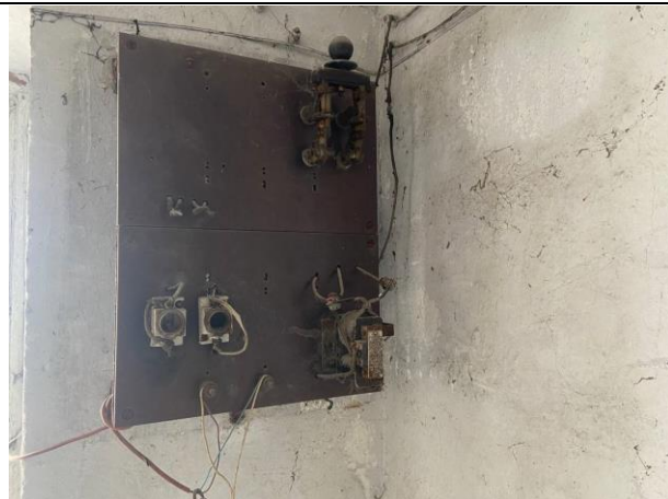
Фото № 24. Внутреннее состояние здания
