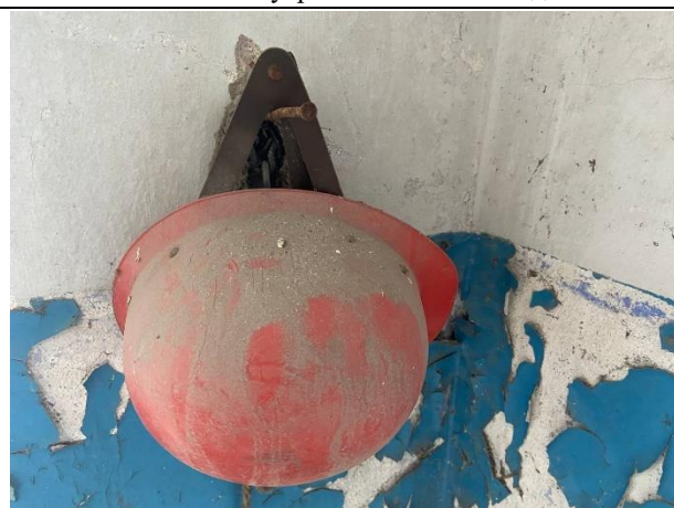
Фото № 26. Внутреннее состояние здания
