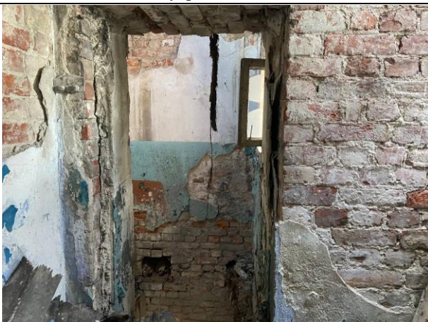
Фото № 19. Внутреннее состояние здания
