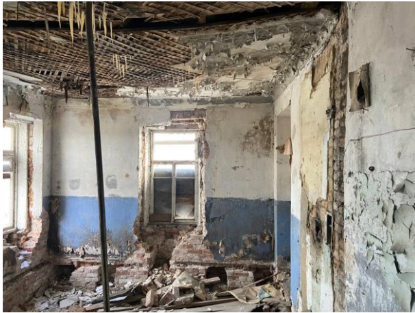
Фото № 15. Внутреннее состояние здания
